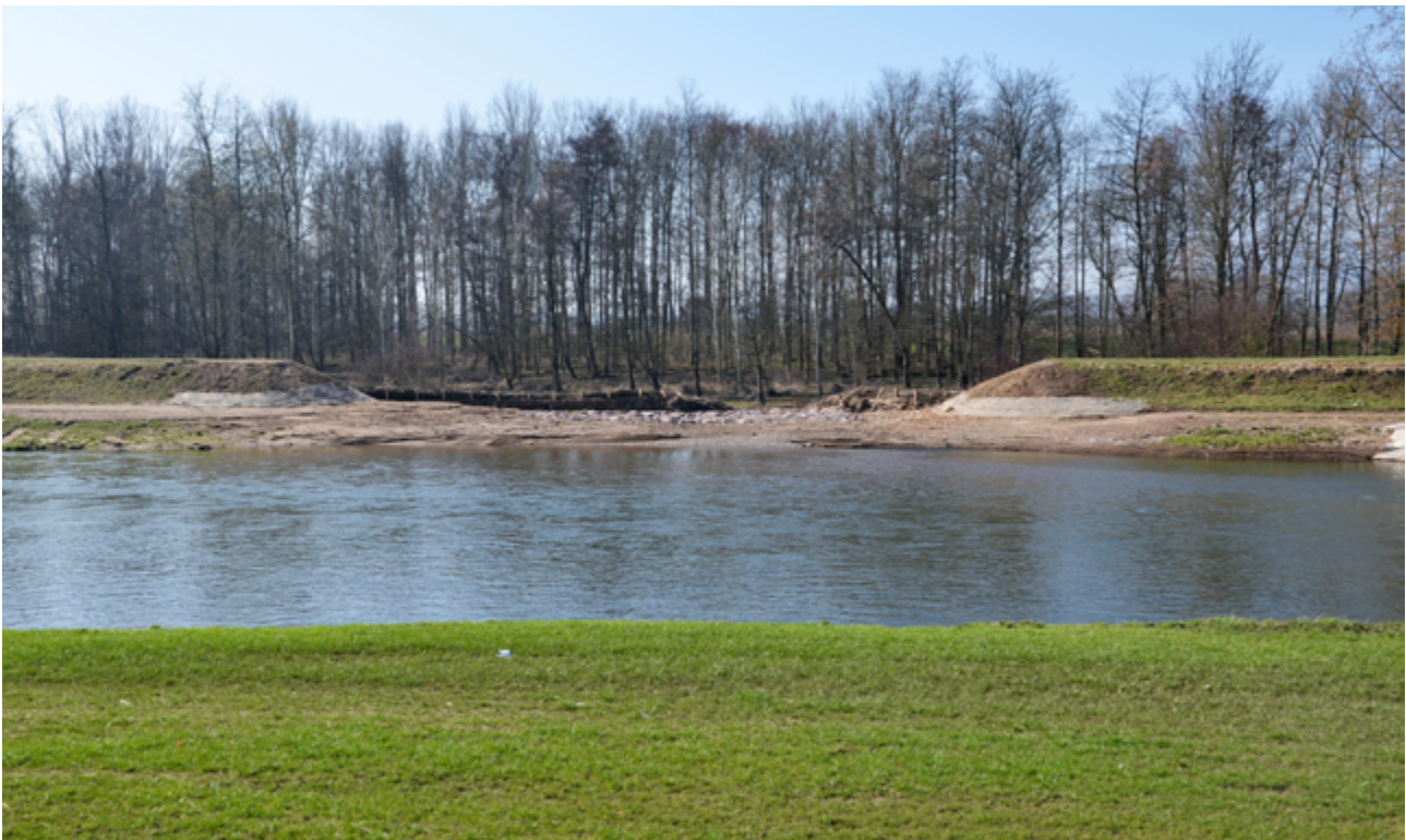
Abbildung 3-7: Deichöffnung und Wiederanschluss eines Auenwalds an die Elz bei Riegel
