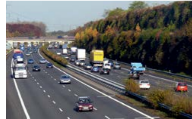
Alltagssituation auf einer Bundesautobahn: Täglich rauschen hier über 80 000 Fahrzeuge vorbei. Eine begrünte Wand schützt die dahinter liegenden Wohngebiete vor dem Lärm.
