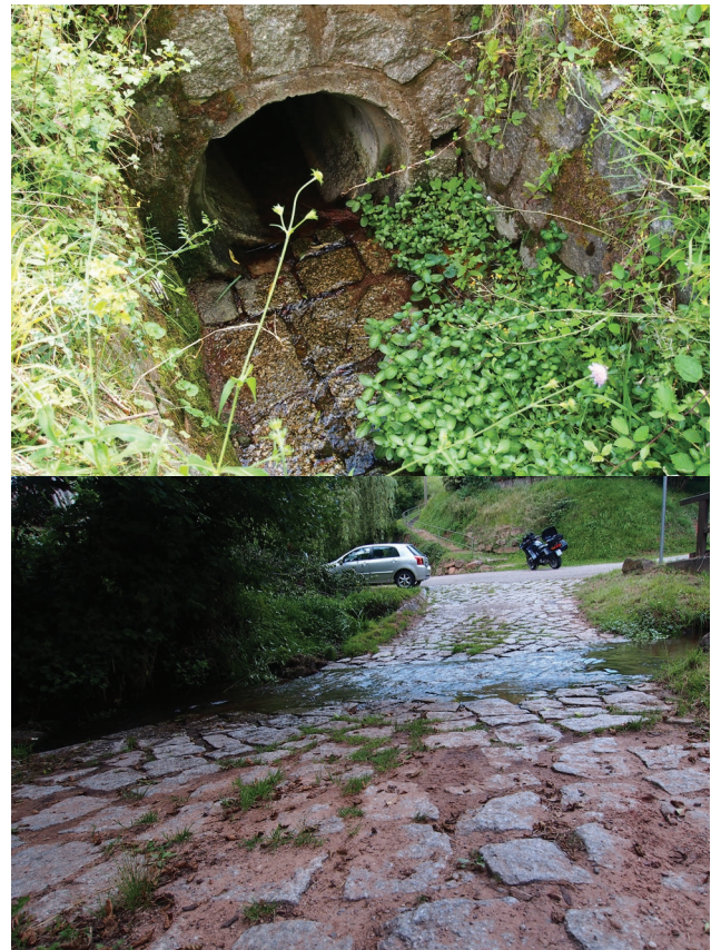
Abbildung 24: So mancher Rohrdurchlass lässt sich durch eine verklausurungsfreie Furt ersetzen (LUBW)
