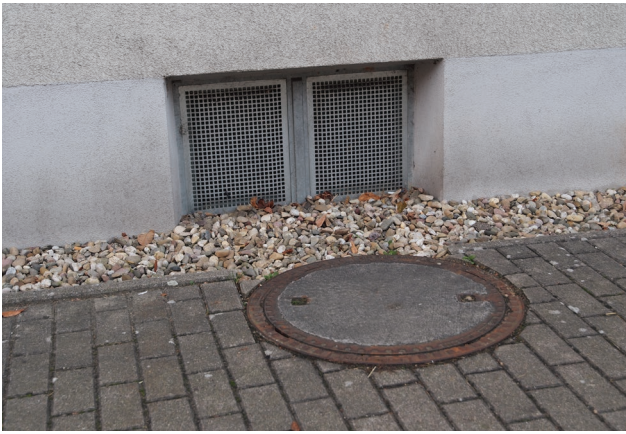
Abbildung 27: Kellerfenster ohne Überflutungsschutz (links); Kellerfenster mit erhöhtem Lichtschacht (rechts) (LUBW)
