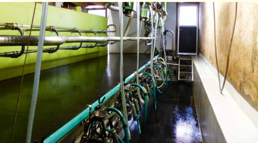
Ins Altgebäude integrierter einreihiger Fischgräten-Melkstand
