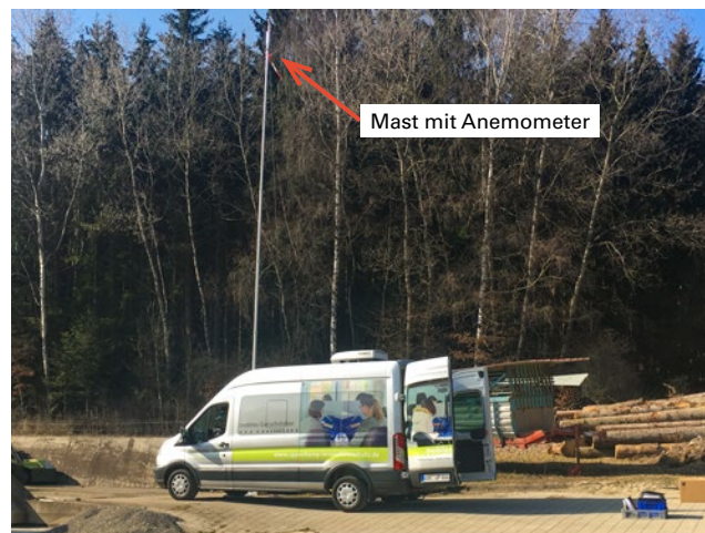
Abbildung 23: Meteorologische Messstation Bild: u+p GmbH
