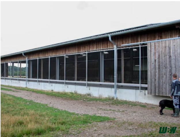
Abbildung 21: Außenansicht Stall MuS II, Südwestseite
