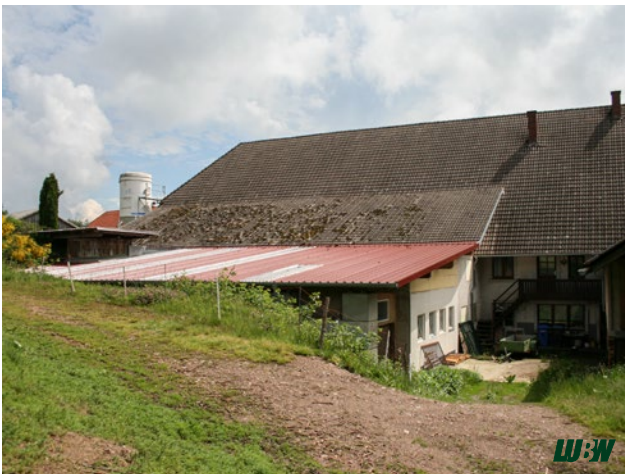
Abbildung 1: Außenansicht Stall MiZ I, Westseite
