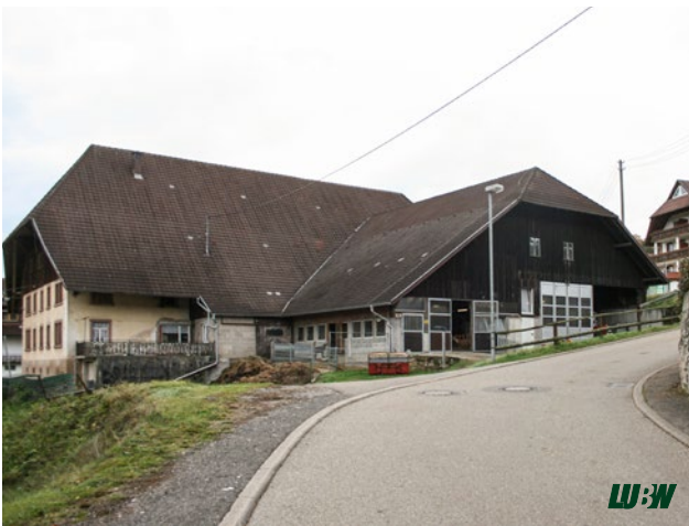
Abbildung 4: Außenansicht Stall MiZ II, Nordseite
