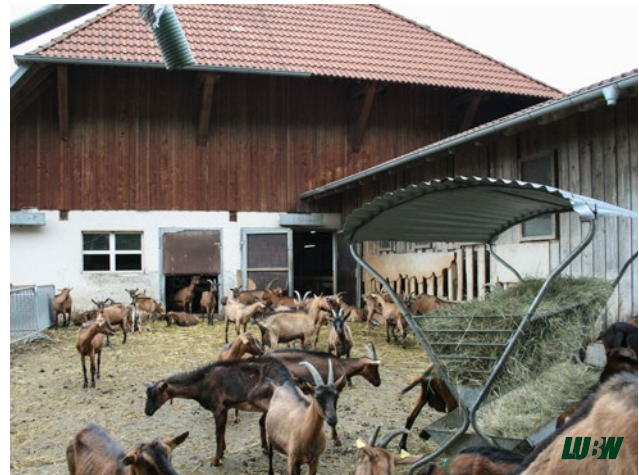
Abbildung 10: Außenansicht Stall MiZ IV, Nordseite
