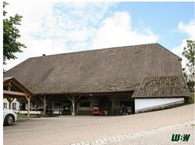
Abbildung 2: Außenansicht Stall MiZ I, Ostseite
