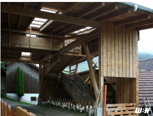
Abbildung 15: Innen-/Außenansicht Neubau MiZ V, Westseite
