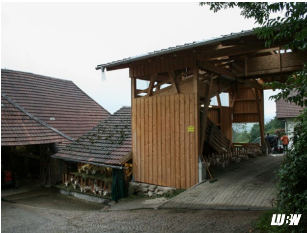
Abbildung 13: Außenansicht Neubau (rechts)/Altbau (links) MiZ V, Ostseite
