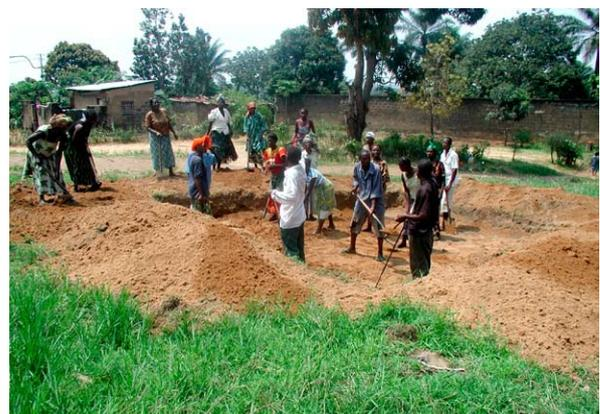
Bau eines Regenrückhaltebeckens in Kisenso mitten auf einer Straße (Foto: Lubuimi 2002)
