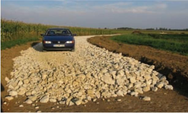
Professioneller Wegebau mit 60 cm Schotterpackung (Wegsicherung in bis zu ein Meter Tiefe). Eine Nasswiese unterhalb eines solchen Weges hat auch in mehreren Dutzend Metern Entfernung keine Überlebenschance mehr, da das zusickernde Bodenwasser vollständig abgefangen wird.
