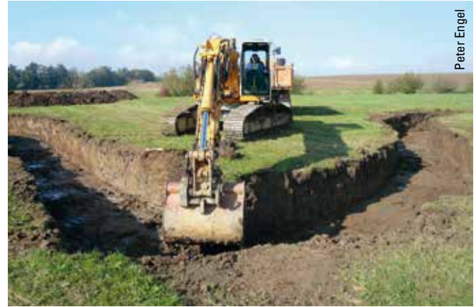
Abbildung 6: Baggern des neuen Bachlaufs mit Rechteckprofil
