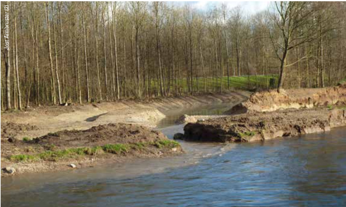
Umgestaltung der Murg in Rastatt Durch die Verlegung des Deiches (im Bildhintergrund) entstand neuer Überflutungsraum. Dies hat enorme positive Auswirkungen für die Natur zur Folge (Maßnahmenfläche 1).
