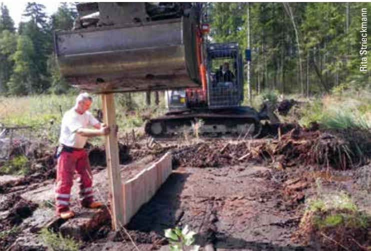
Ein Bagger half mit: Bei einem Teil der 25 Stauwehre im Haubacher Moos wurden Spundwände aus Holz eingerammt.
