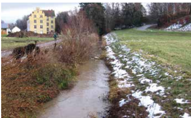
Abbildung 1: Der Sixenbach vor der Renaturierung (links) – mit einem gestreckten Lauf mit etwa 1,5 Metern Tiefe und einer Bordbreite von 6 Metern. Nach der Renaturierung ist der Lauf mäandrierend mit einer Tiefe von durchschnittlich 0,7 Metern und einer mittleren Breite von 1,4 Metern.
