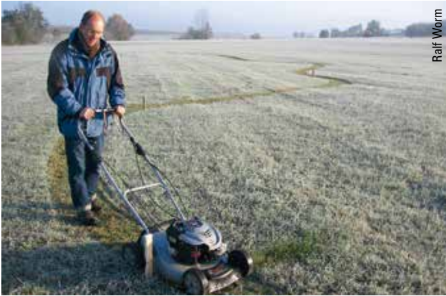
Abbildung 5: Trassenmarkierung mit Pflöcken und Rasenmäher
