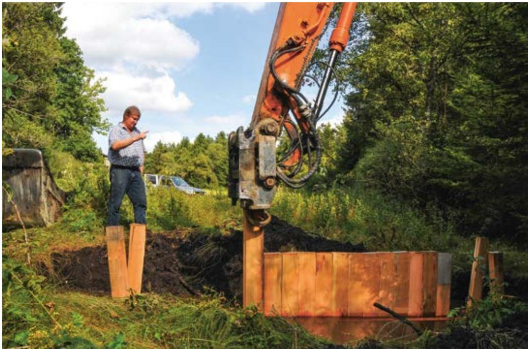
Abbildung 9: Einbau einer Abflusssperre im Waltere Moor
