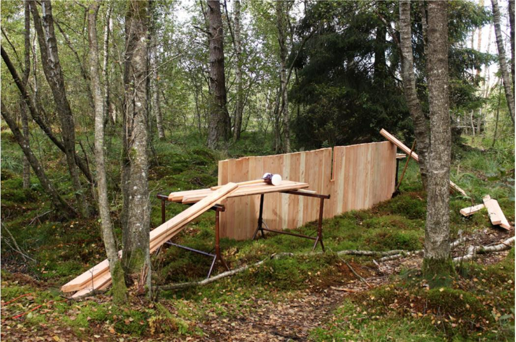
*Abbildung 6.8: Mit dem Bau von Grabensperren, wie hier im Fördergebiet Schwenninger Moos, sollen die hydrologischen Verhältnisse im Moor stabilisiert werden. Foto T. Kring/NGP Baar*
