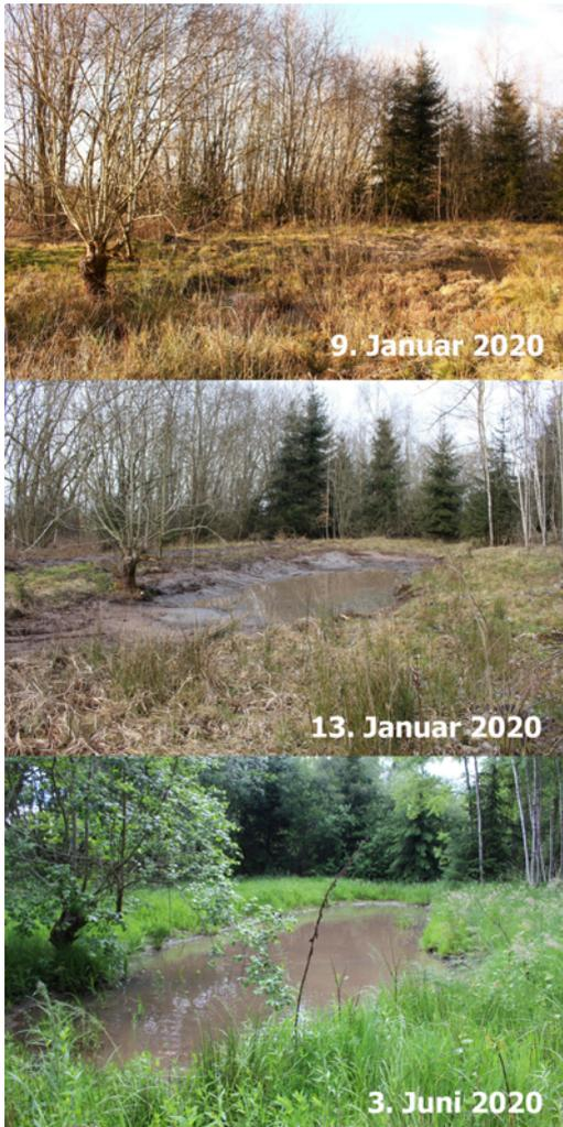
Abbildung 6.9: Im Fördergebiet Riedseen wurden vier kleinere Tümpel freigestellt und entschlammt. Die Abbildung zeigt die Situation vor und nach der Maßnahme sowie rund fünf Monate später. Fotos/Montage: T. Kring/NGP Baar
