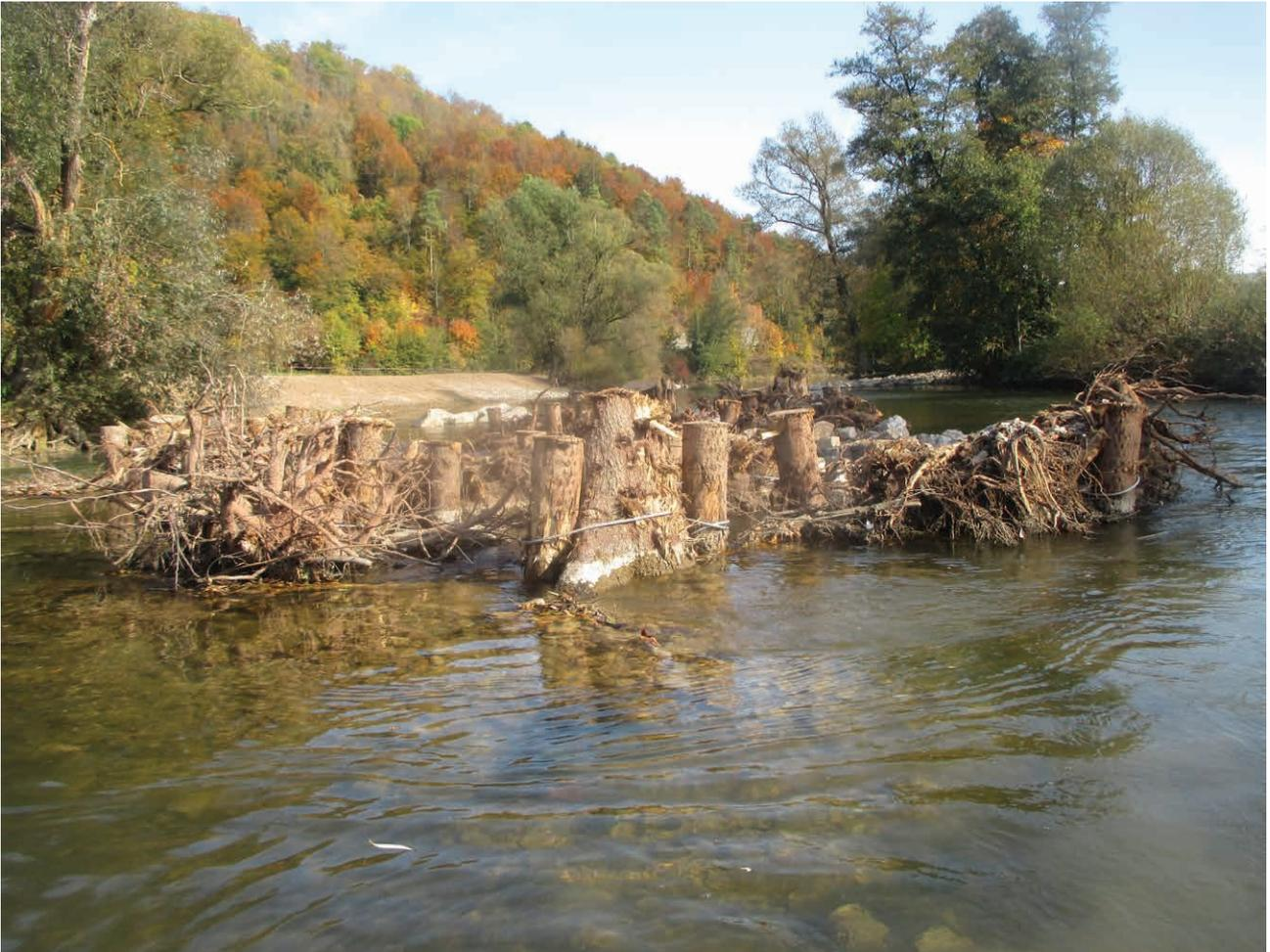
Abbildung 3-4: Beispielhafte Wurzelstocksicherung
