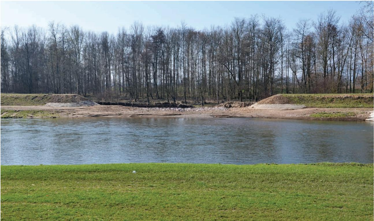
Abbildung 3-7: Deichöffnung und Wiederanschluss eines Auenwalds an die Elz bei Riegel
