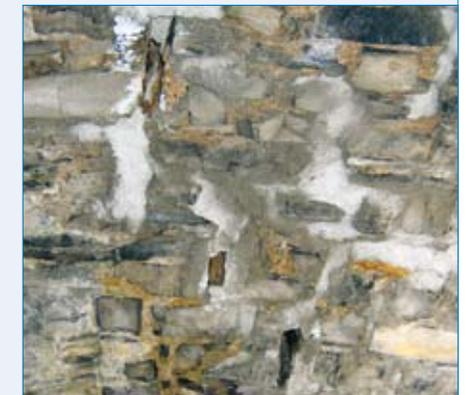
Abbildung 22. Die Unterseite der Lisconny Brücke, Irland. Im Bild die drei Teile der tiefen Spalte, die für die Wochenstubenkolonie von *Myotis daubentonii* offen gelassen wurde. Die Kolonie befindet sich in dem unteren Abschnitt. Man beachte, wie sorgfältig das Mauerwerk ausgefugt und nicht überdeckt wurde.
