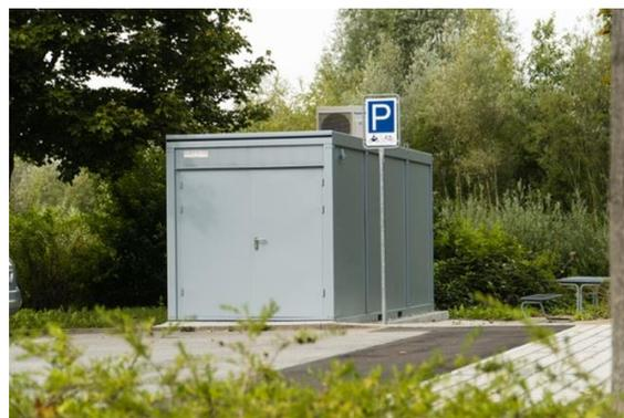
*Klimatisierter Container mit Batterie, Leistungselektronik und Kommunikationstechnik*
