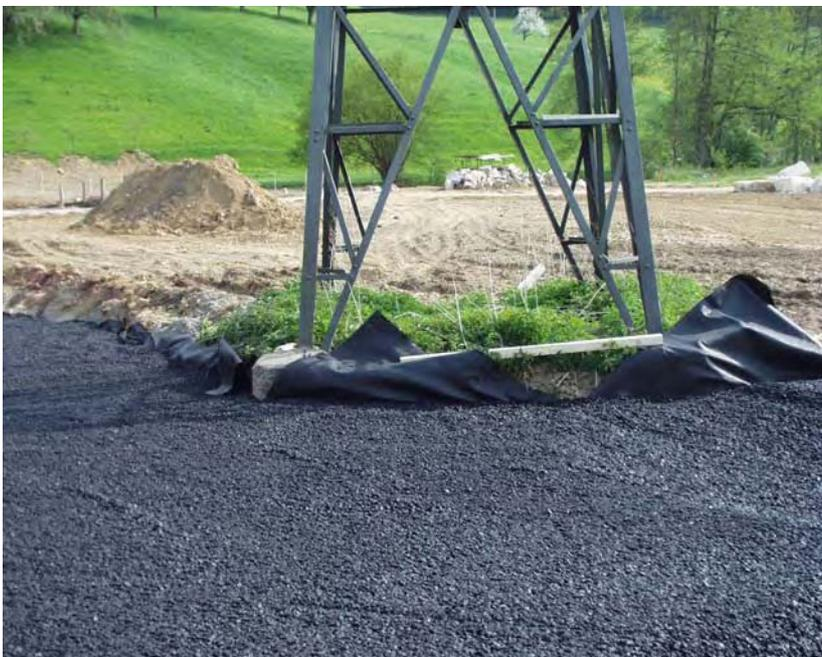
Durch Flussbausteine auf dem Mastix-Schotter wird das anströmende Wasser umgeleitet
