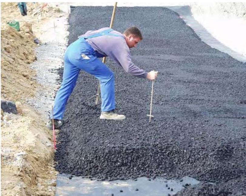
Durch Einstecken einer Eisenlehre wird die Einbaustärke kontrolliert
