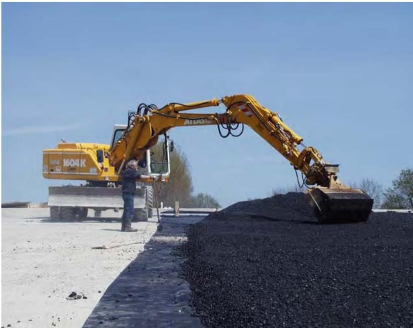
Mit einem Bagger mit schwenkbarem Grabenlöffel wird der Mastix-Schotter verteilt, glattgezogen und angedrückt
