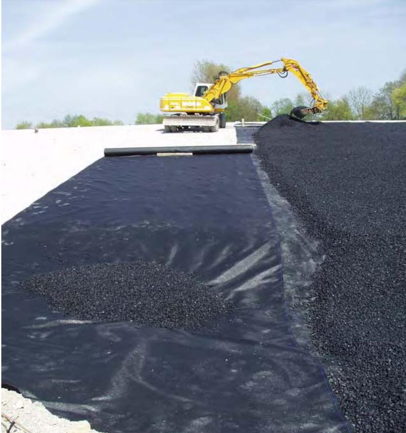
Das Geogewebe wird bahnenweise direkt vor dem Einbau des Mastix-Schotters ausgerollt
