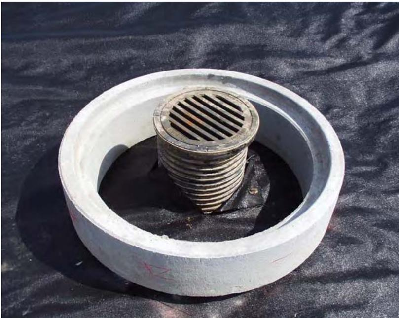
Eine unter dem Damm verlaufende Entwässerungsleitung machte den Einbau eines Schachts notwendig; das Schachtrohr wird vollständig mit dem Geogewebe eingeschlagen
