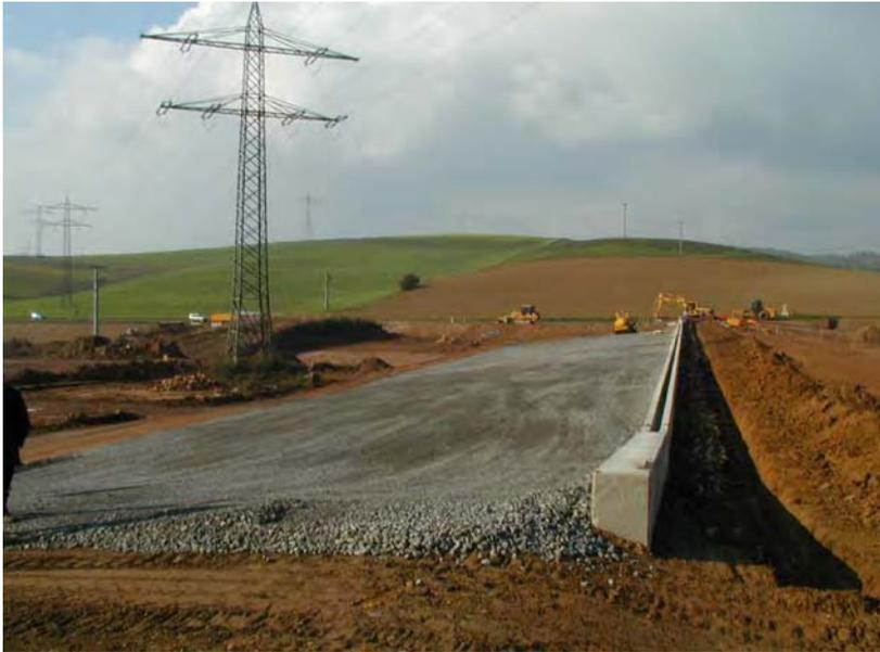
Blick auf die Dammkrone und die Mineralschotterschicht (als Unterbau für das Mastix-Schotter-Deckwerk)
