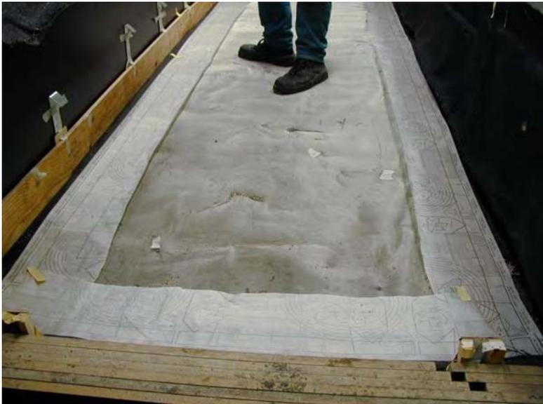
Randliche Trennlage aus Papier, um das Anhaften des Deckwerkes am Klebebitumen zu unterbinden.
