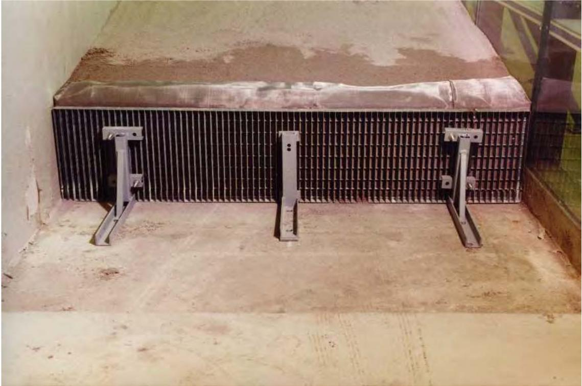
**Foto 4** Stützung des Sandkörpers am Böschungsfuß
