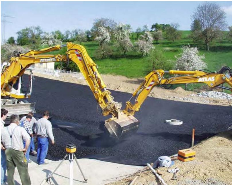
Die Ausformung des Kolkbereichs wird mit Hilfe des Baggers ausgeführt
