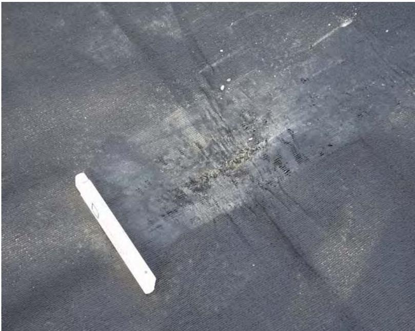
Eine Beschädigung im Geogewebe wurde großflächig mit einer zusätzlichen Lage überdeckt
