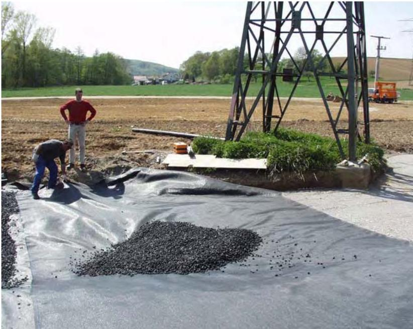
Ein Strommast direkt am Dammfuß machte eine Umformung des Kolkbereiches erforderlich
