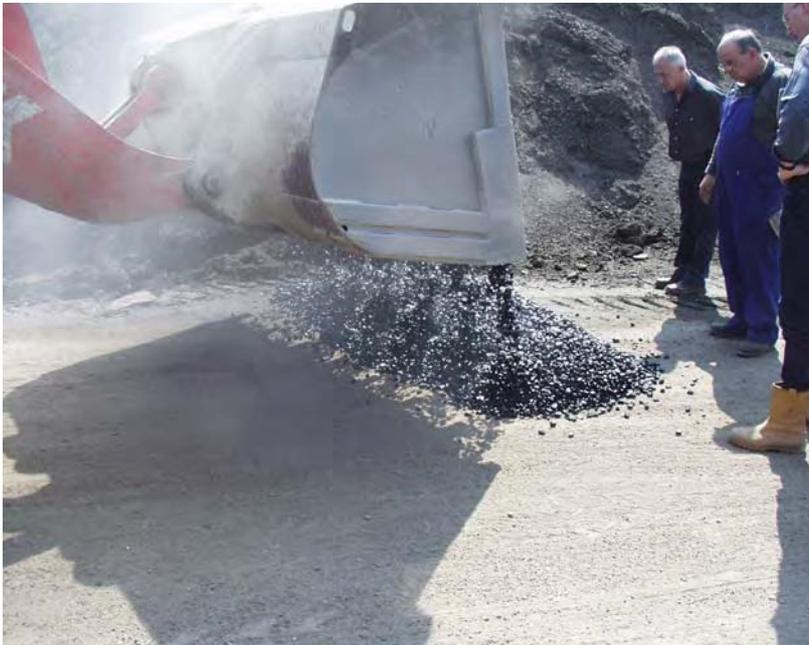
Herstellung von Probemischungen zur Einstellung des Mischwerks vor Beginn der Bauarbeiten
