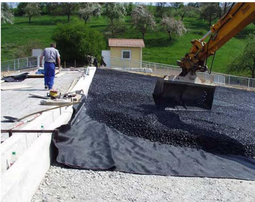
Durch eine Schlaufenlage im Geogewebe soll Materialaustrag bei etwaigen Verformungen am Anschlußbereich verhindert werden
