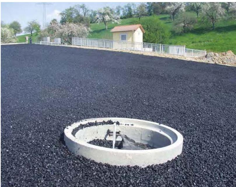
Nach Herstellung des Deckwerkes wird der Schachtring mit Beton verfüllt
