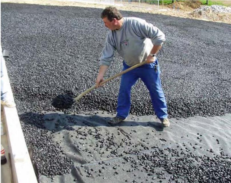
Von Hand wird die Schlaufenlage fixiert und die Fuge an der Überlaufschwelle sicher geschlossen (Vermeidung von Hohllagen)
