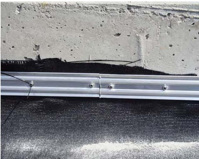
An der Überlaufschwelle wird das Geogewebe mit Klemmleisten fixiert
