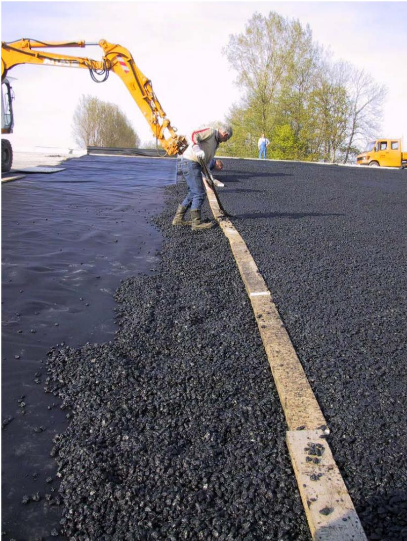
Beim Arbeitspausen über Nacht werden Kanthölzer an der Fuge ausgelegt; bei Wiederaufnahme der Arbeiten wird die Fuge mit Primer angesprüht und erwärmt
