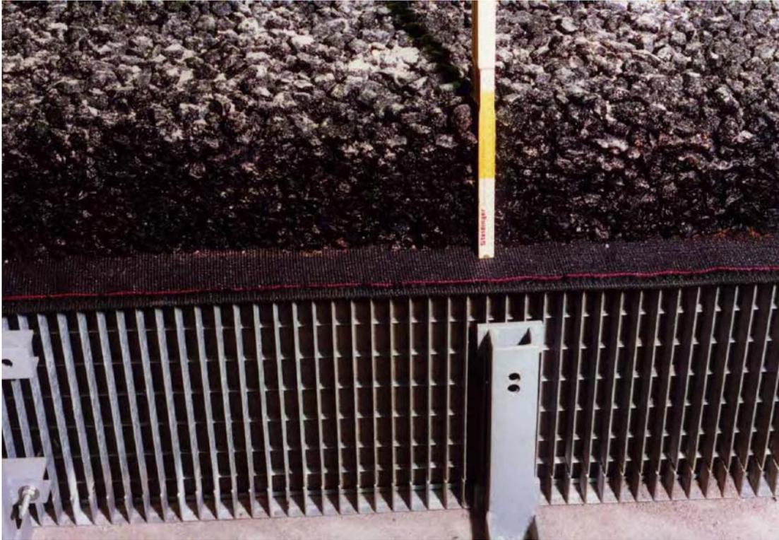
**Foto 9** Detailaufnahme des Mastix-Schotters: Einbauhöhe ca. 15 cm
