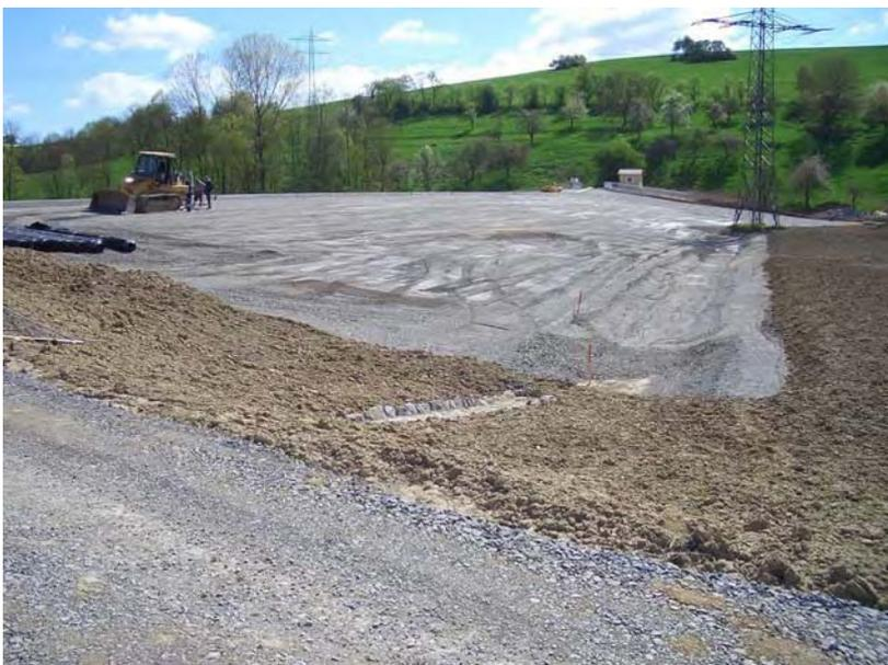
Blick von unterstrom auf die fertiggestellte Mineralschotterschicht mit Ausformung des Kolkbereiches
