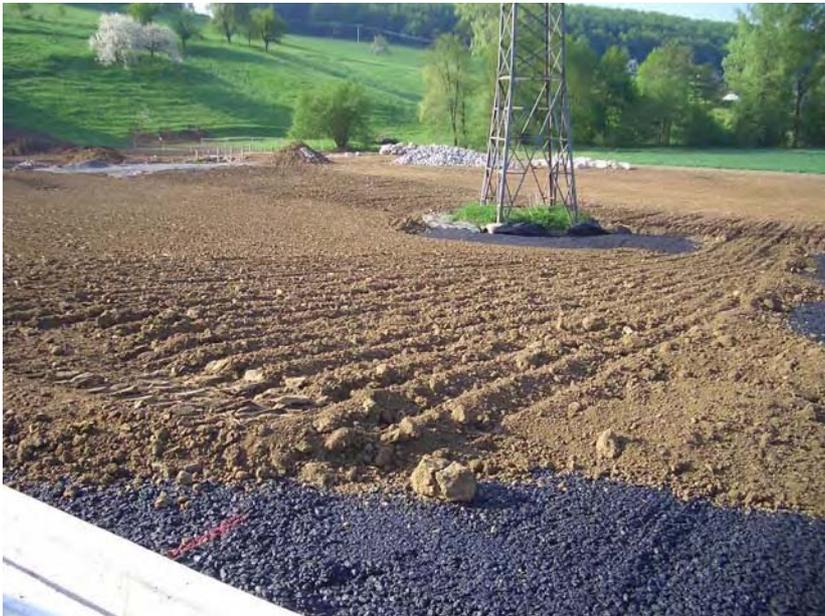
2 Tage nach der Fertigstellung des Deckwerkes kann der Oberboden aufgetragen werden
