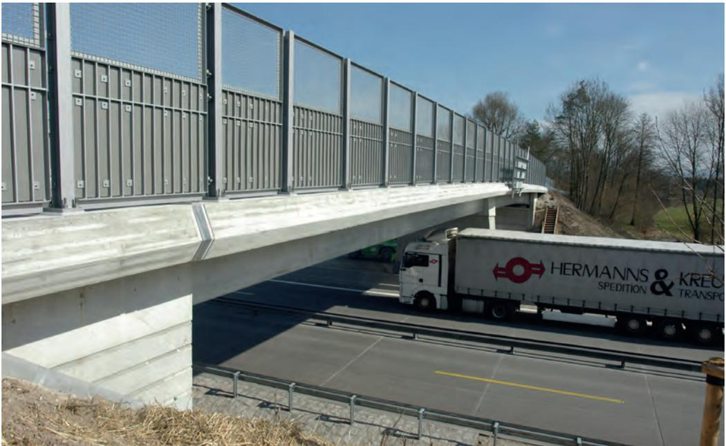
Abbildung 7: Überführungsbauwerk mit Blendschutz
