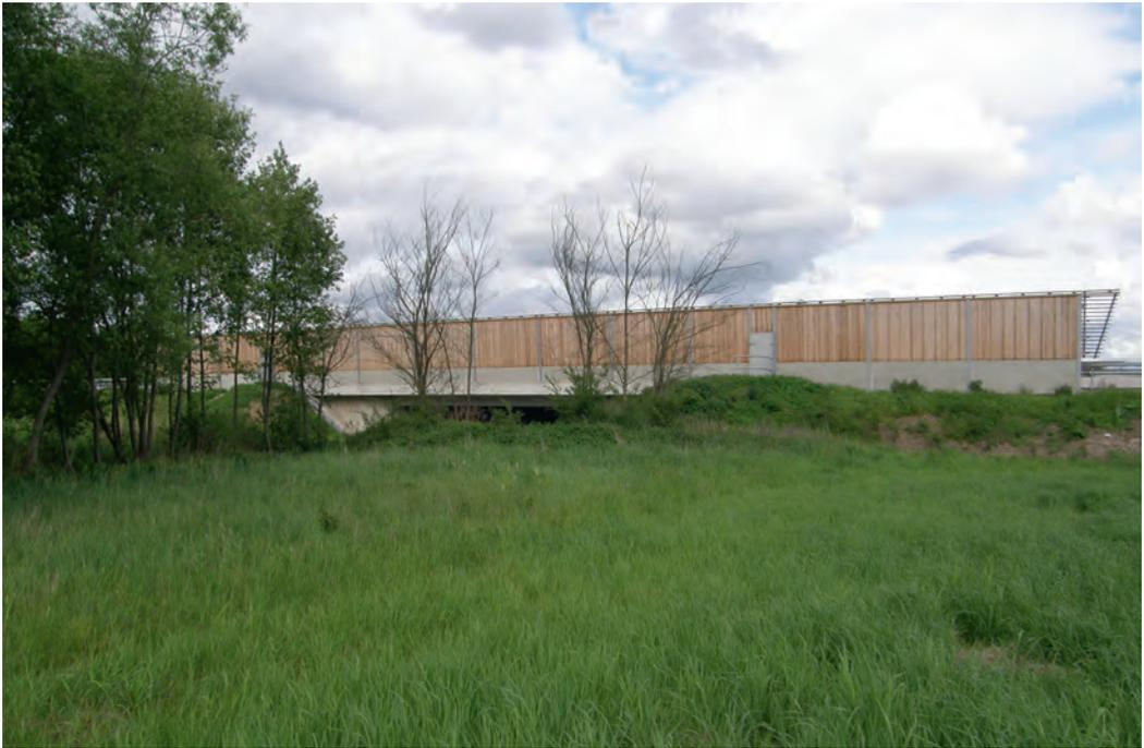
Abbildung 8: Unterführungsbauwerk mit Irritationsschutzwand
