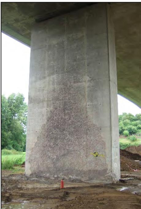
Brandschaden mit Betonabplatzungen an einem Pfeiler
