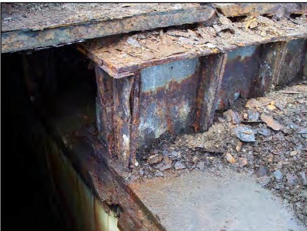
Starke Korrosion an der Konstruktion eines
