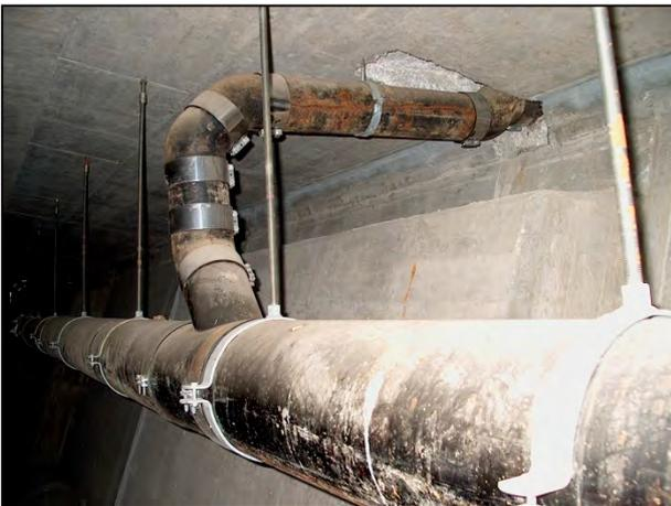
Gerissene und korrodierte Entwässerungsleitung
