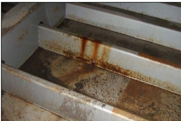
Bodenplatte im Innenbereich eines Stahlhohlkastens mit Korrosion aufgrund Wassereindringens
