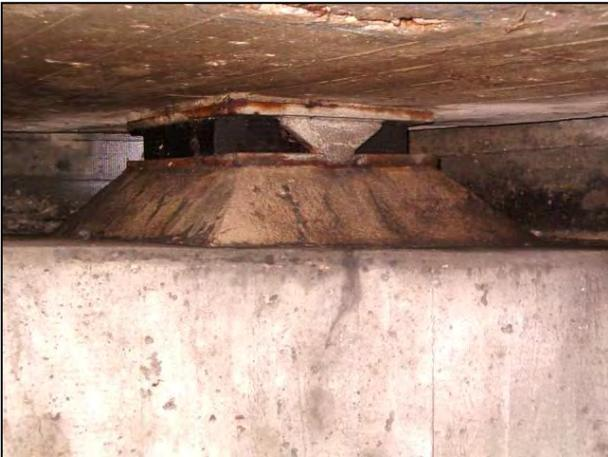
Korrodierte Lagerplatten eines Elastomerlagers
