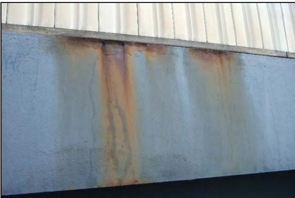
Gesimsblech eines Stahlüberbaus mit Korrosion an der oberen Kante (Foto: SH Ingenieure GbR)
