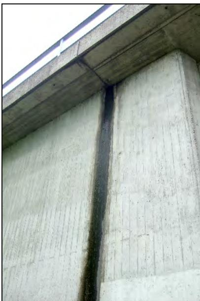
Undichte Fuge am Übergang Widerlager – Überbau (Foto: SH Ingenieure GbR)
