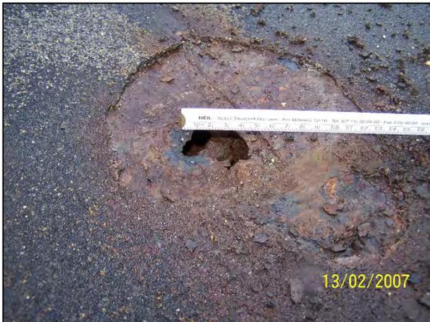
Starke Korrosion mit Durchrostung an einem Deckblech der Brückentafel
