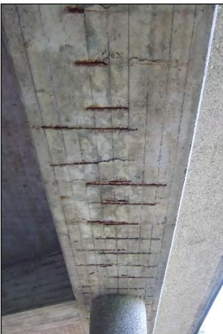
Bewehrungskorrosion mit Abplatzungen an einem Überbausteg (Foto: SH Ingenieure GbR)
