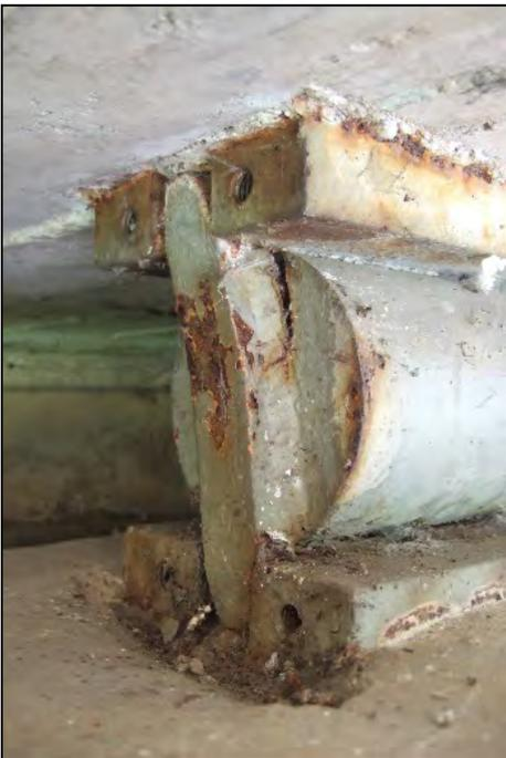
Gerissenes und korrodiertes Rollenlager
