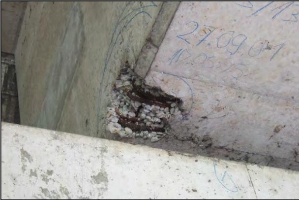
Kiesnest und freiliegende Bewehrung an einem Hohlkastensteg (Foto: SH Ingenieure GbR)
