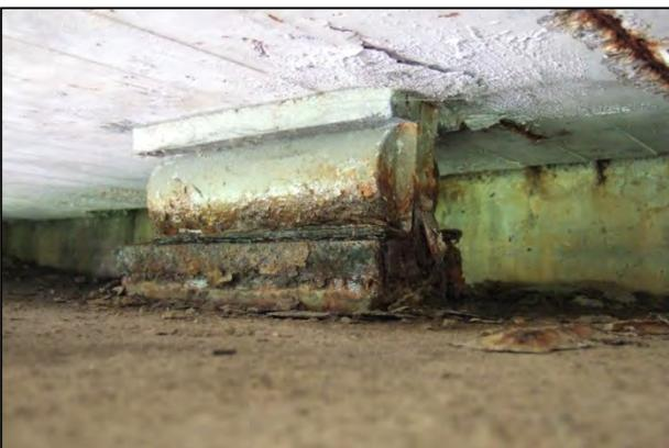
Stark korrodiertes Rollenlager
