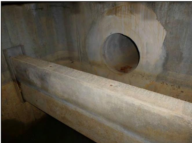
Unzureichende Tauchwandwirkung durch den fehlenden Dauerstau, der sich durch die Undichtigkeit des Schachts nicht einstellen kann
