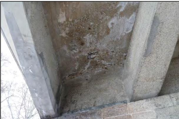
Durchfeuchtete Überbauplatte mit Bewehrungskorrosion und Betonabplatzungen (Foto: SH Ingenieure GbR)
