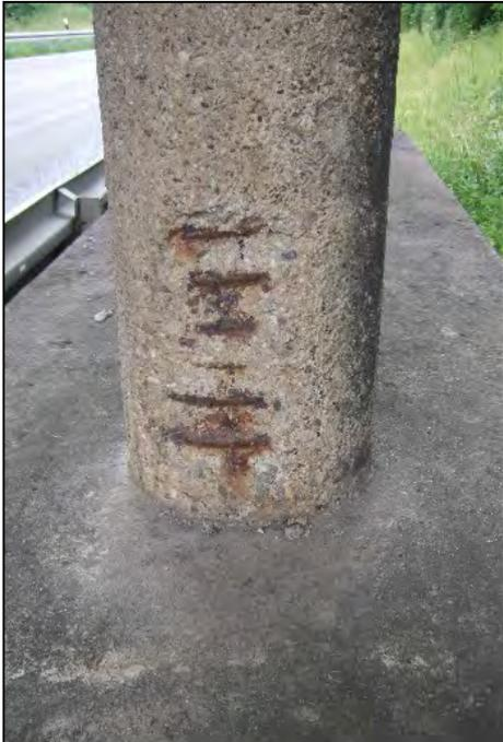
Bewehrungskorrosion an einem Stützfuß
