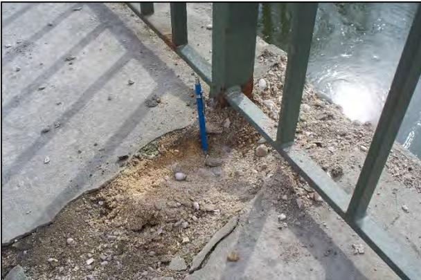
Zersetzter Beton an einer Kappenoberfläche
