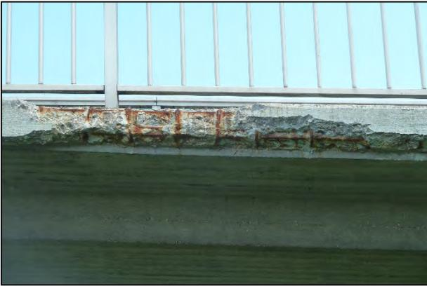
Gesims mit Betonabplatzungen aufgrund Bewehrungskorrosion (Foto: SH Ingenieure GbR)
