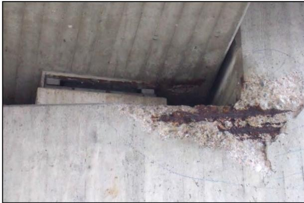
Betonabplatzung und Bewehrungskorrosion an einer Widerlagerwand (Foto: SH Ingenieure GbR)
