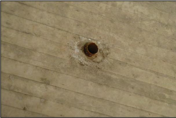
Korrodierte Tropftülle an Unterseite Überbau
