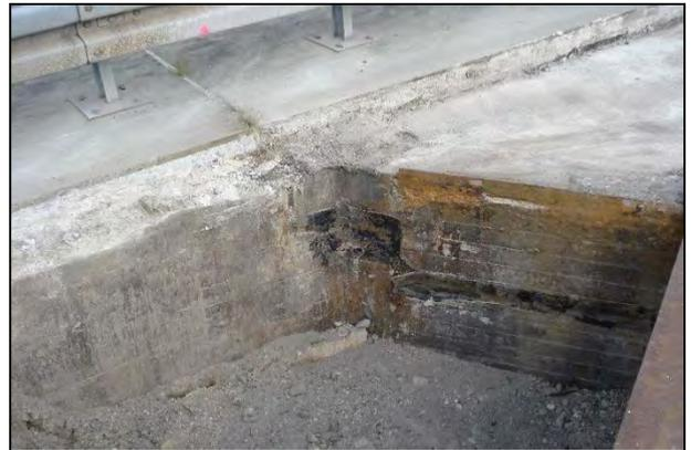
Offene Fuge zwischen Widerlager und Überbau im Hinterfüllbereich (Foto: SH Ingenieure GbR)
