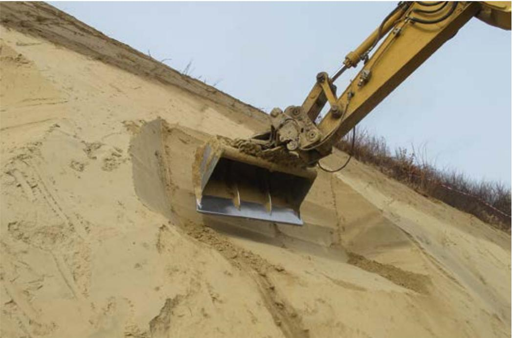
Abbildung 4: Die Halde unterhalb der Steilwand und die Seiten werden abgeschrägt (Achkarren-Schneckenberg, Februar 2011)
