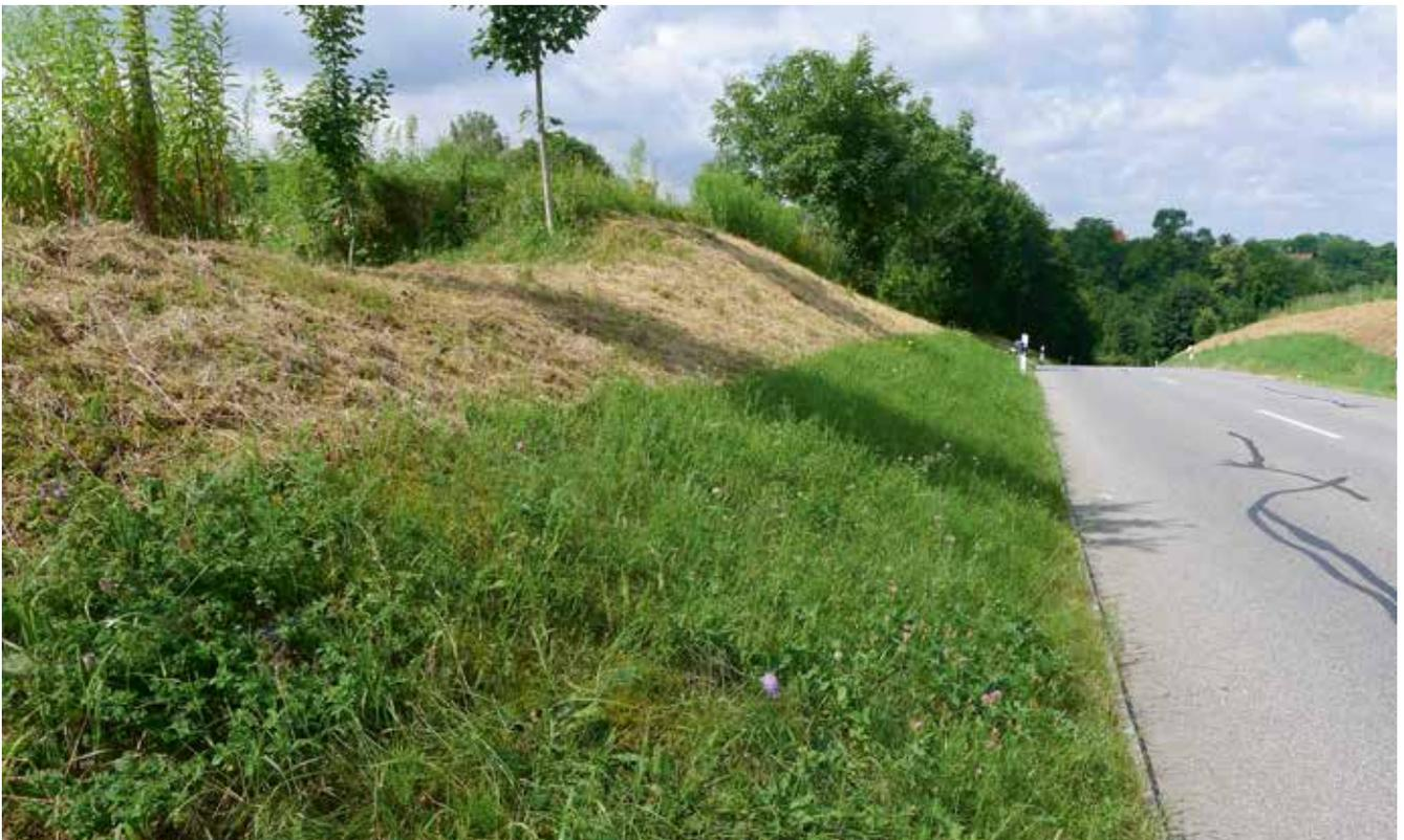
*Wie in diesem Bild sollte der Extensivbereich erst nach dem Schnitt des Intensivbereichs / der Bankettzone gepflegt werden.*
