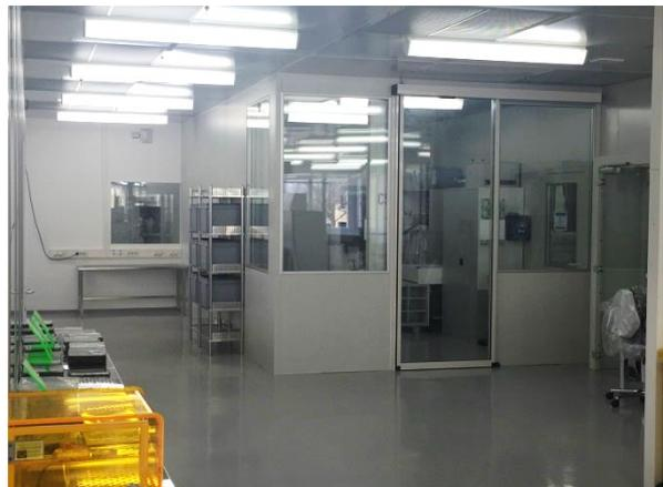
Abbildung 3: Blick auf die Personen- und Materialschleuse über die der Reinraumbereich betreten und verlassen werden kann.
