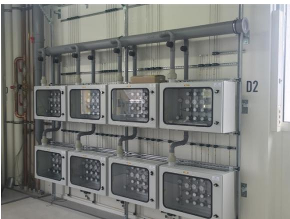
Abbildung 4: Gasverteilsystem (Spezial- und Hausgase)
