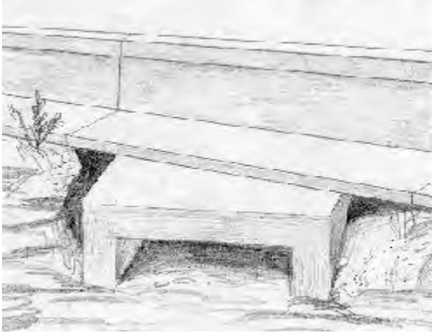
**Mangelnde Abstimmung der Durchlassanschlüsse kann zu gravierenden Fehlkonstruktionen führen bis hin zur völligen Untauglichkeit der Schutzanlage. B078:**
