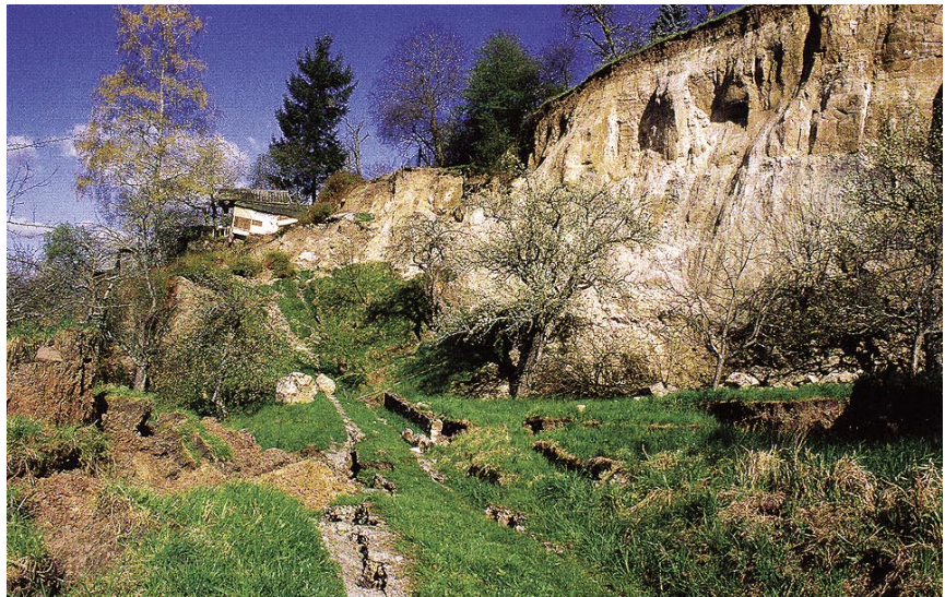
Berggrutsch im Kiesel sandstein und in den Unteren Bunten Mergeln bei Urbach (Remstal)
