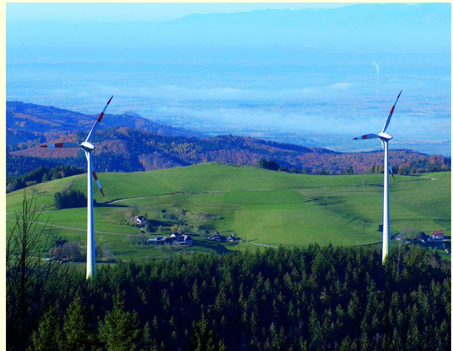
Viele Windkraftanlagen befinden sich in Südbaden auf bewaldeten Höhenrücken. Hier ein Blick über die Holzschlägermatte bei Freiburg in die Rheinebene.
