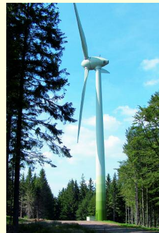
Bei der Errichtung von Windkraftanlagen in Wäldern werden häufig kleine Waldflächen gerodet. Dabei können Lebensstätten insbesondere von solchen Fledermäusen beeinträchtigt werden, die in Höhlen und Spalten von Bäumen Quartier beziehen. Für andere Arten wie die Zwergfledermaus und den Kleinabendsegler, die vorrangig an Waldändern und auf Lichtungen jagen, steigt die Attraktivität als Jagdgebiet.
