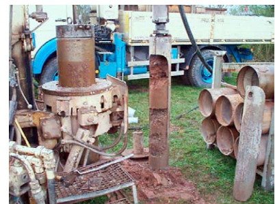
Bohrverfahren bei größeren Tiefen
