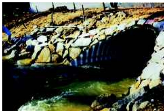
Abb. 3c: Durch einen Großdurchlaß ist die Verbindung zwischen dem Rhein und einem Altrhein wieder hergestellt worden.
