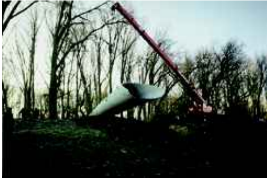
Abb. 3a: Einbau eines Großdurchlasses
