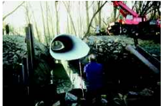
Abb. 3a: Einbau eines Großdurchlasses
