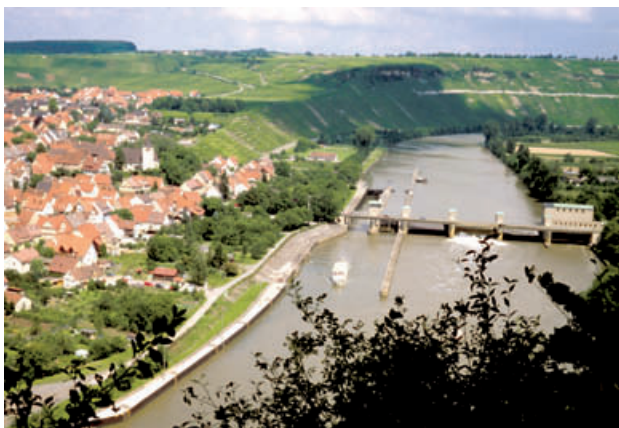
Für einen weiteren Schleusenausbau müssen landschaftsverträgliche Lösungen gefunden werden.
