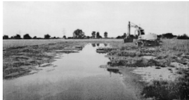
Anlage von permanent wasserführenden Flachwasserbereichen.
