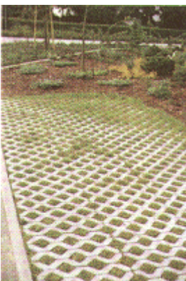
Abb. 32 Befestigungsvarianten von Rasenplätzen - Schotterrassen - Rasenpflaster /45/:
