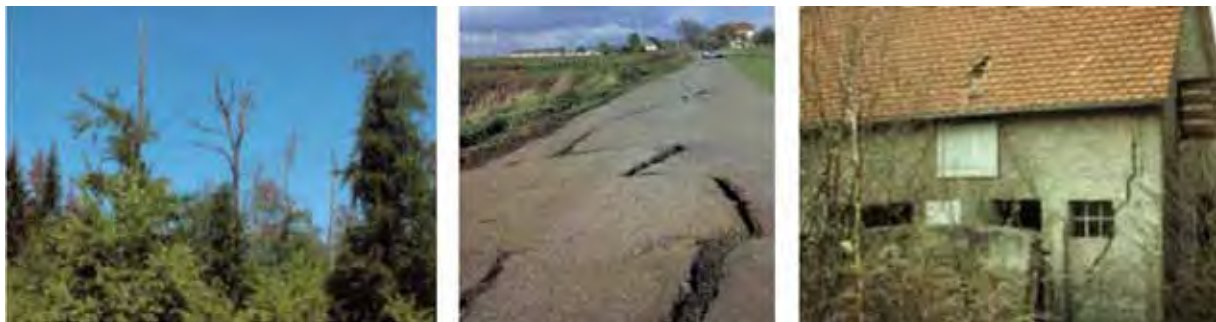
Abb. 1: Trockenheitsschäden im Wald und Setzrissschäden an Verkehrswegen und Gebäuden infolge extrem niedriger Grundwasserstände
