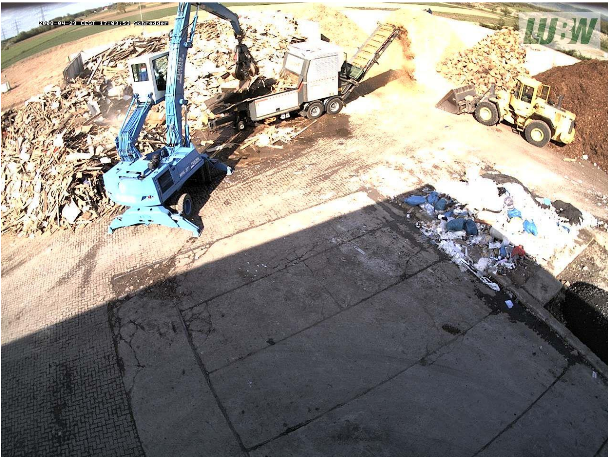
Abbildung 6-8: Sichtbare Staubentwicklung bei der Aufnahme per Greifer in Segment 5 (unterhalb der Steuerkabine)
