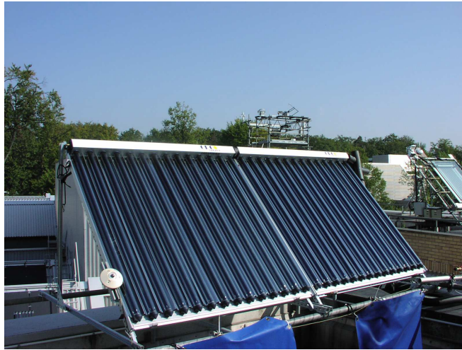
Abb. 5.5: Kollektorfeld der Versuchsanlage
