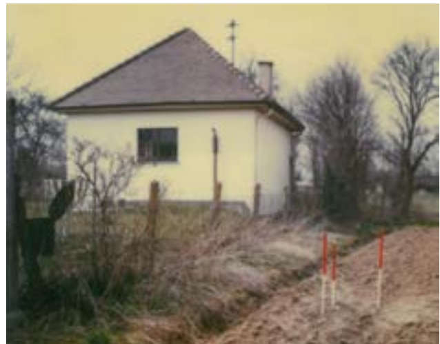
Abbildung 2.1-2: Lysimeteranlage Weisweil am Kaiserstuhl. Der Lysimeterbehälter (GW-Nr. 0500/068-5) wurde unter einer Ackerfläche an der mit Fluchtstäben markierten Stelle eingebaut.
