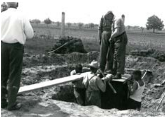
Abbildung 3.2-2: Einbau des Lysimeters Durmersheim (Monolith, GW-Nr. 0503/210-4) am 23. April 1968. Bild: unbekannt
