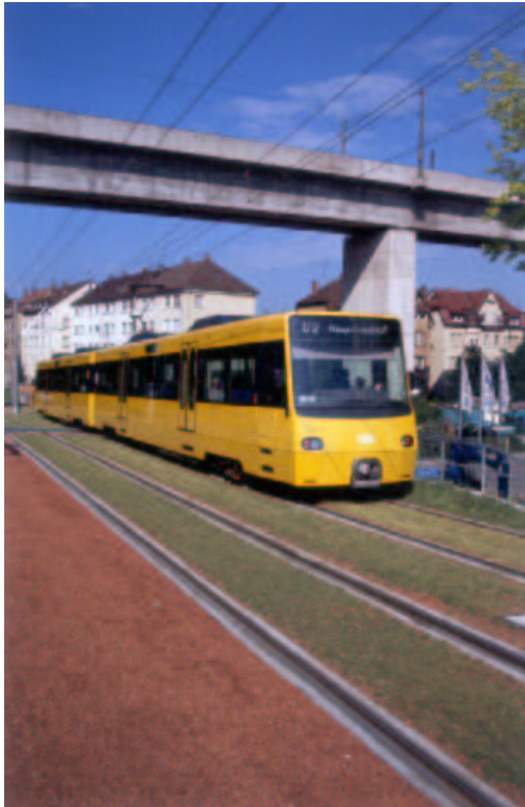
Abbildung 7.1: Rasengleis Schmidener Straße nach dem Umbau
