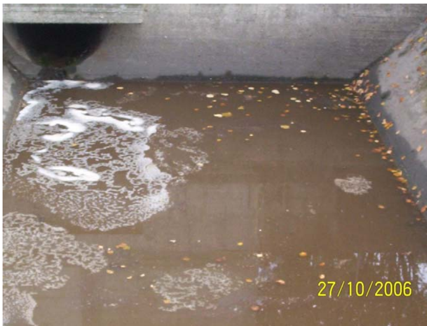
Bild 1: Der Zulauf zum RKB Abelt ist Oberflächenwasser aus einem Trennsystem. Er macht optisch einen verschmutzten Eindruck. Im Herbst kommt Laub, im Frühjahr Blütenstaub hinzu. Fehlanlüsse von Schmutzwasser an den Regenwasserkanal, optisch kenntlich an Toilettenpapier oder Hygieneartikeln, konnten hier nicht nachgewiesen werden.
