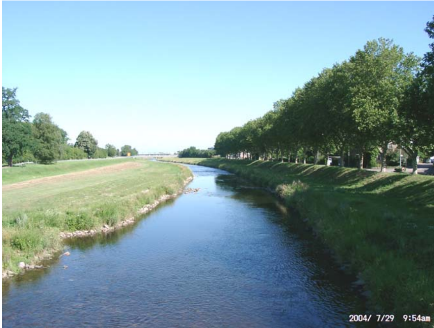
Abb. 2.18: Die als Doppeltrapezprofil ausgebaute Murg bei Gaggenau im Kreis Rastatt. Deutlich zu erkennen sind die grasbewachsenen Vorländer, welche an das Mittelwasserbett anschließen. Das Gewässer wird beidseitig von Deichen eingegrenzt; hinter den Deichen sind Verkehrswege, Besiedlung oder Industrie bzw. Gewerbe. Eine eigendynamische Gewässerentwicklung kann hier aufgrund des massiven Ausbaus und der Sicherungen nicht stattfinden. (Aufnahme: Lehmann)
