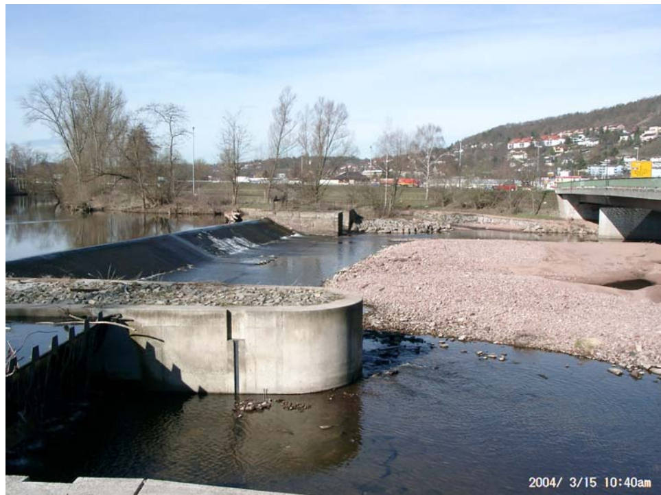
Abb. 3.30: Anlandung von Feststoffen im Bereich einer Gerinneaufweitung unterhalb einer Wehranlage bei Niefern/Enz ca. drei Kilometer unterhalb der Untersuchungsstrecke Pforzheim/Enz. (Aufnahme: Lehmann)
