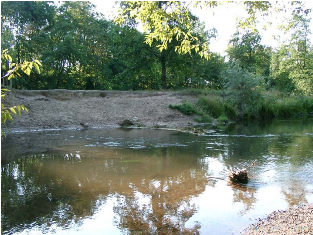
Abb. 2.17: Uferabbruch an der unteren Alb bei Karlsruhe-Daxlanden. Da hier ein ausreichend breiter Uferrandstreifen vorhanden ist, findet kein Verbau des „beschädigten“ Ufers statt. Dadurch entstehen flache Uferbereiche, die einen wichtigen Übergang vom Wasser zum Land darstellen (amphibischer Bereich). Zur Vermeidung einer unerwünschten Vergrößerung des Abbruchs wäre hier eine Böschungfußsicherung mittels Steinsatz und/oder Lebendverbau möglich. (Aufnahme: Lehmann)
