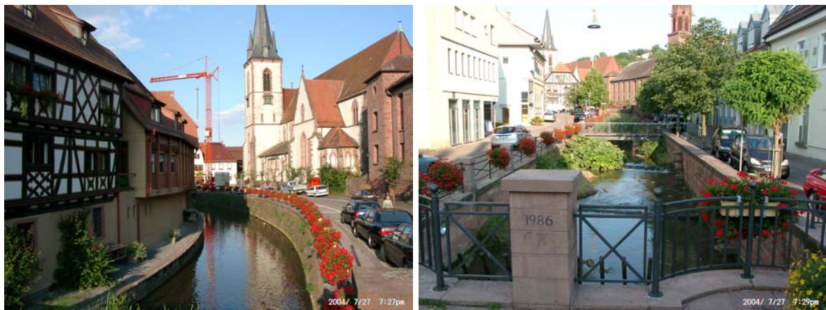
Abb. 2.14: Gewässerkosmetik ohne wirkliche Verbesserung der gewässerökologischen Merkmale. Links: Gewässer im ausgebauten Zustand. Rechts: Durch fachlich fehlerverstandene „Renaturierungen“ überwuchert der zugelassene Bewuchs die eigentliche harte Verbauung des Baches. Zudem kann sich eine solche Maßnahme sehr nachhaltig negativ auf die Hochwassersicherheit auswirken.
