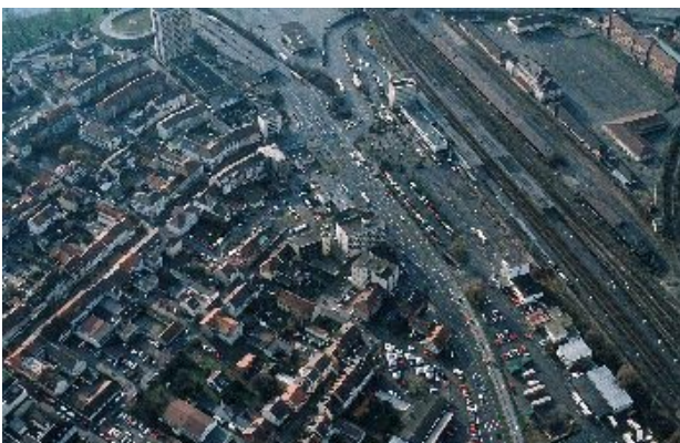
Ungenutzte Brachfläche der Bahn und des Militärs
