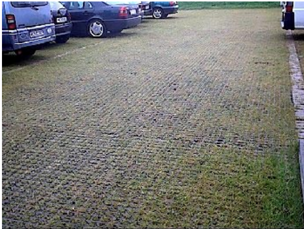
Auch stark frequentierte Parkplätze können mit wasserdurchlässigen Belägen gestaltet werden Foto: M. Theis
