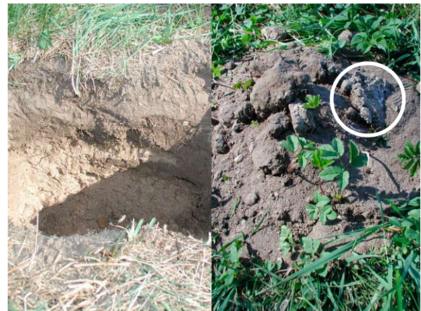
Oberboden im Bereich 0-5 m Entfernung zum Fahrbahnrand, Auffüllung Oberboden auf sandigem Kies der Niederterrasse, Betonreste im Unterboden
