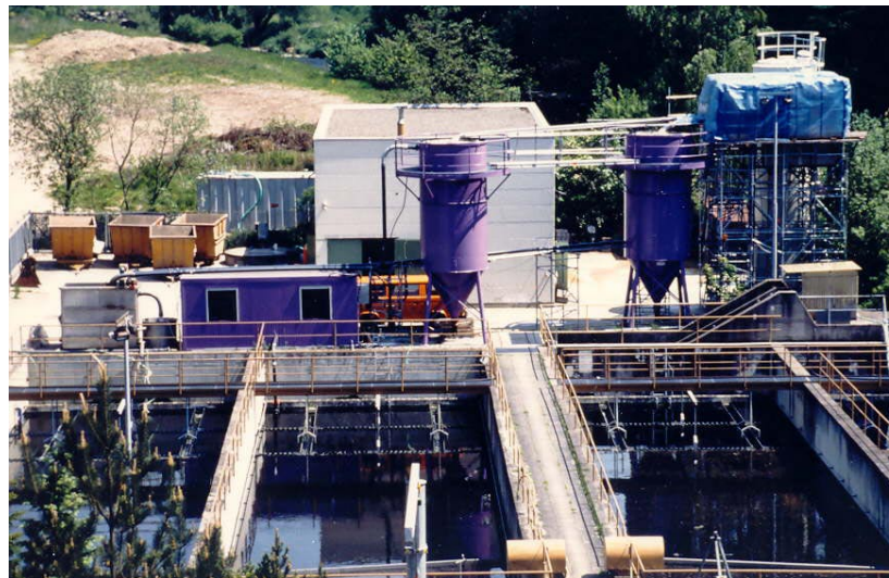
Bild 10: Versuchsanlage zur Nachfällung mit Kalkhydrat auf der Kläranlage Oberndorf-Aistaig (1992)
