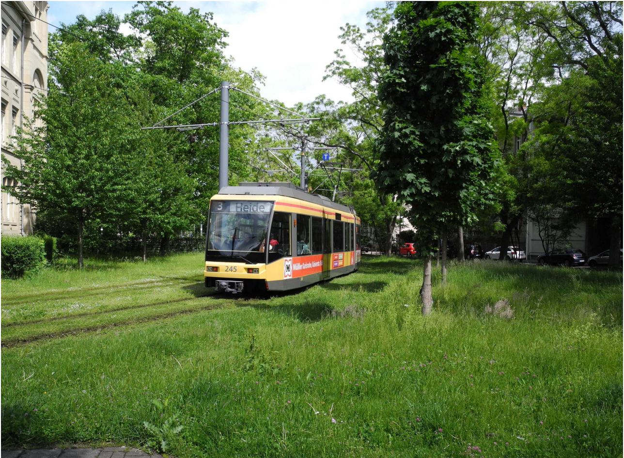
Abbildung 73: Begrünte Gleistrasse in Karlsruhe Nordstadt (Foto: Baumüller)
