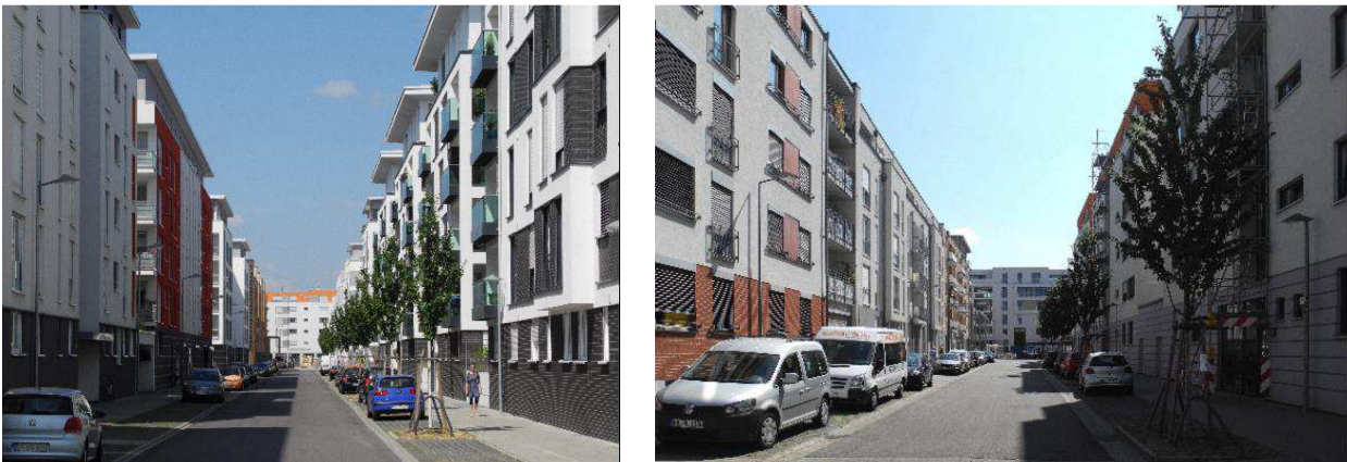
Abbildung 88: Baumpflanzungen in Karlsruhe Oststadt auf der „richtigen“ (linke Abbildung) und „falschen“ Seite (rechte Abbildung) (Foto: Baumüller)
