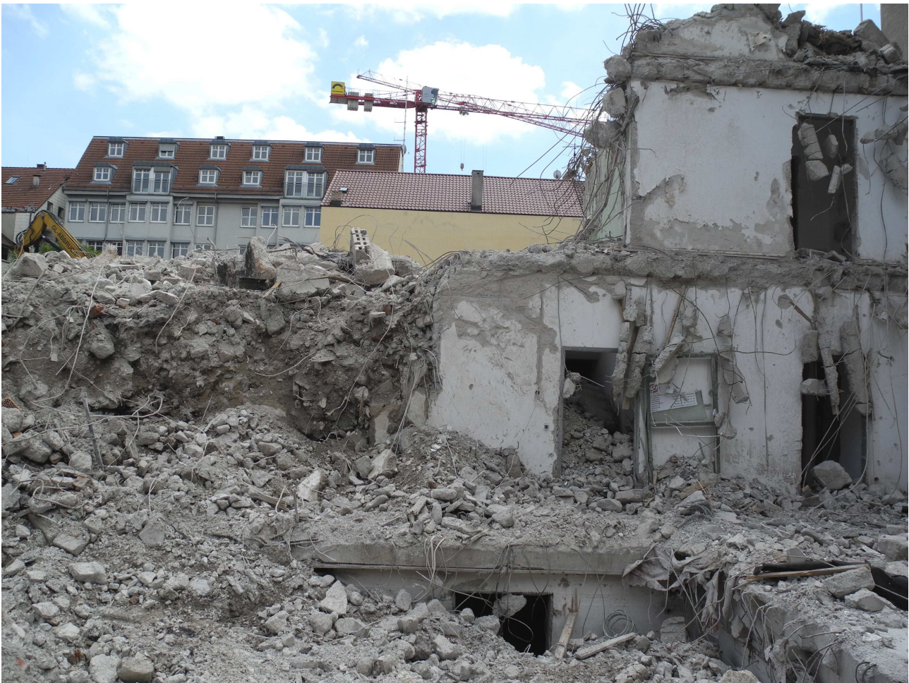
Abbildung 50: innerstädtische Rückbaumaßnahme (Foto: Baumüller)
