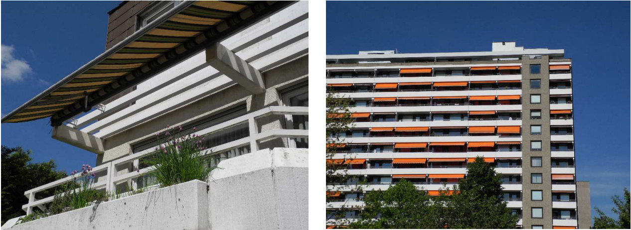
Abbildung 87: Verschattungselemente an Wohnhäusern (Fotos: Baumüller)
