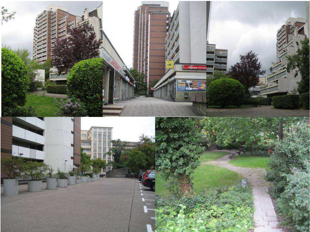
Abbildung 142: Impressionen aus dem Hot-Spot Quartier des Stadtstrukturtyp 08 „Hochhausgebiete mit überwiegender Wohnnutzung“
