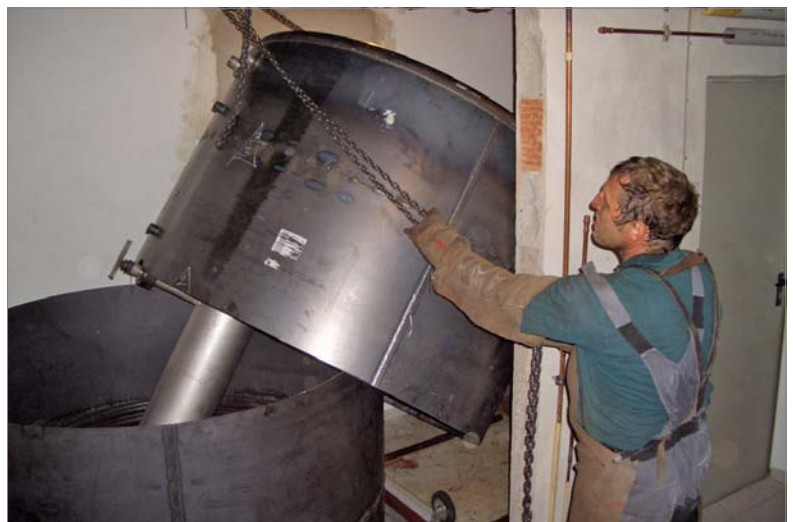
Aufwändiger Einbau eines Wärmespeichers in einem engen Keller
