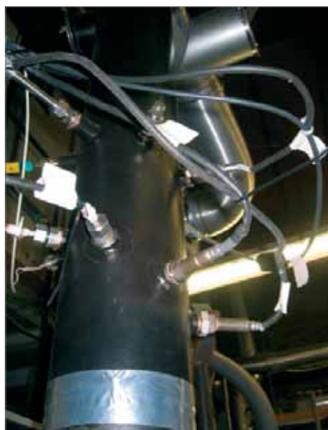
Anordnung der Sensoren im Abgasrohr einer Holzfeuerung
