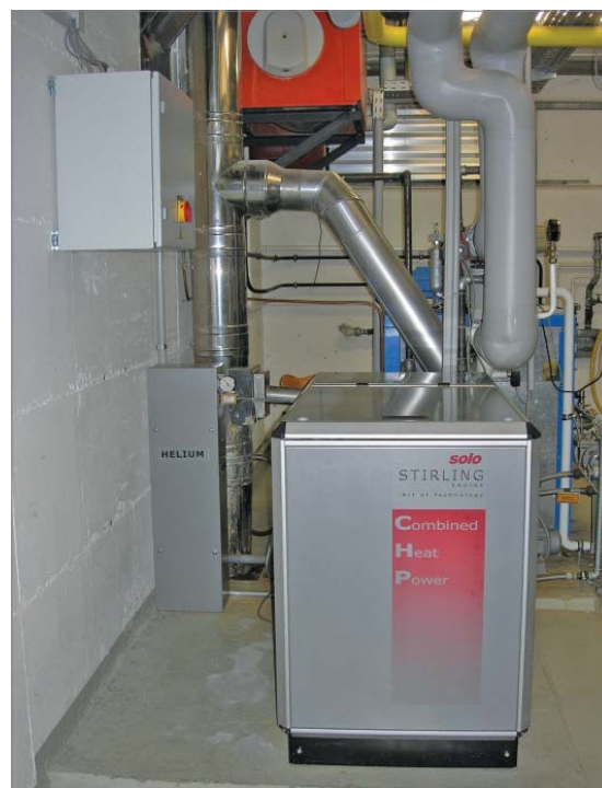
Klein aber fein: Stirling-KWK-Modul in der Kläranlage Rosenfeld
