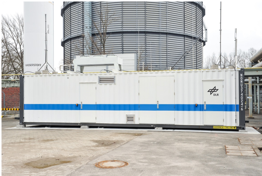
Abbildung 8: Installiertes PEM Elektrolysesystem (Jan. 2016) inkl. Blitzableitung, Gasausbläsern und Tischkühlern
