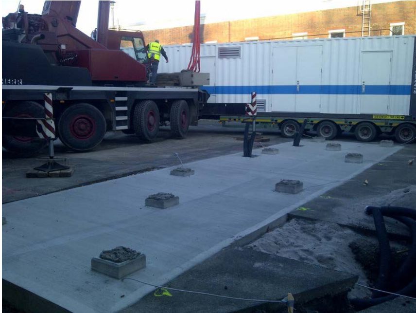
Abbildung 6: Tiefbauarbeiten: Bodenplatte inkl. Blitzschutz-Ableitungen und Auflagepunkten für den Container (Bild vom Dez. 2015)
