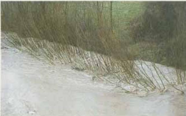
Abb. 5: Weidenfaschine, die schon seit 15 Jahren allen Hochwasserereignissen standhält und die Ufer stabilisiert – Murr/Erdmannshausen (Aufn. LfU 1994).
