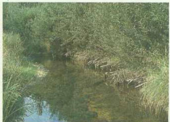
Abb. 8: Spreitlage zur Böschungssicherung, stark unterspült, da fehlende Fußsicherung (Aufn.: LfU 1995).
