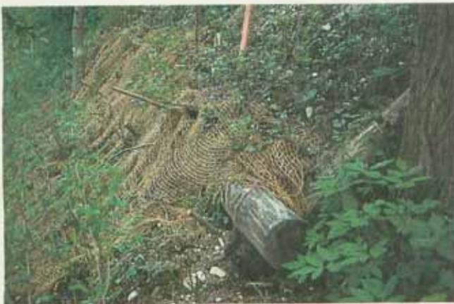
Abb. 2: Baumaterialien naturgemäßer Bauweisen: Hangroost aus Rundholz (Fichte), Weidenstecklinge, Jutegewebe (natürliche, verrottbare Faser) (Aufn.: LfU 1994).
