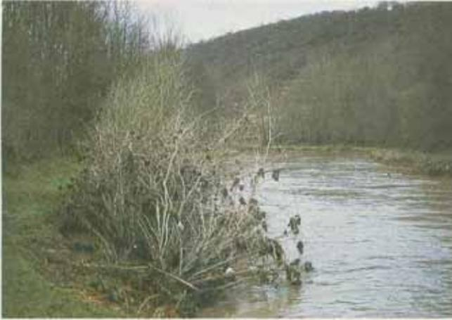
Abb. 13: Die hydraulischen Belastungen sind an der Sohle und im unteren Böschungsbereich besonders groß. Die hier vereinzelt stehenden Weiden wurden hinterspült, was zu Ufererosionen führte – Murr/Steinheim (Aufn.: LfU 1993).
