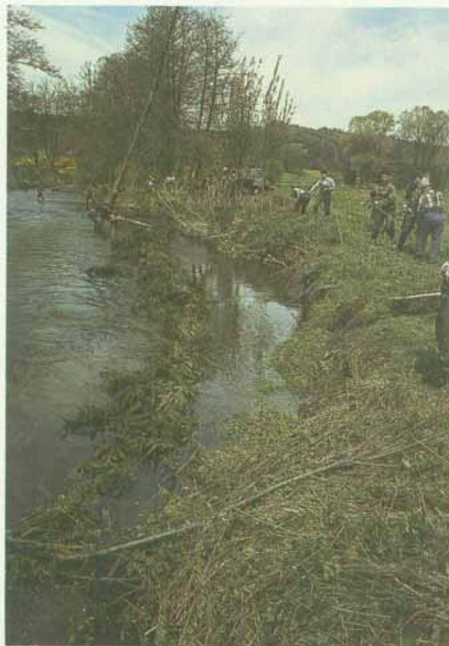
Abb. 12: Sanierung eines längeren Uferabbruchs durch Rauhbäume. Eine naturgemäße Bauweise, die sich für Schwebstoff- und Sedimentführende Gewässer eignet. Die Aufnahme stammt aus dem Jahr 1989 – eine Wiederherstellung der früheren Uferlinie wäre aus heutiger wasserrechtlicher Sicht nicht mehr erforderlich (Aufn.: Bönecke 1989).
