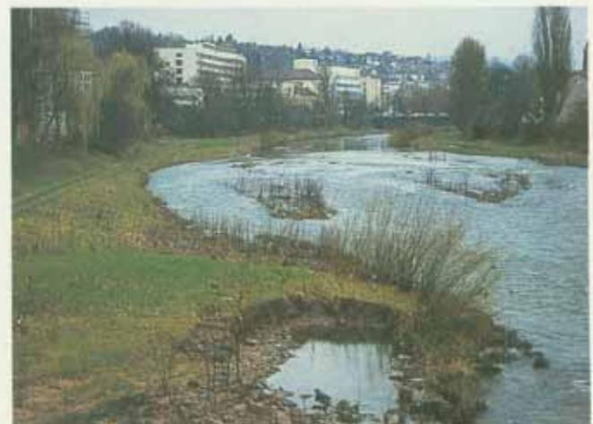
Abb. 16: Umgestaltung der Enz in Pforzheim, nach Hochwasserereignis 12/93. Hinterspülte Faschine: Hauptursache war die auf die exponierte Bauweise frontal auftreffende Strömung (Aufn.: LfU 1994).
