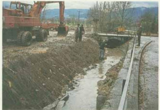
Abb. 21: Spreitlage zur Böschungssicherung (in Ortslage) (Aufn.: LfU 1992).
