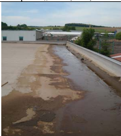
Auf dem Dach des Bettenhauses
