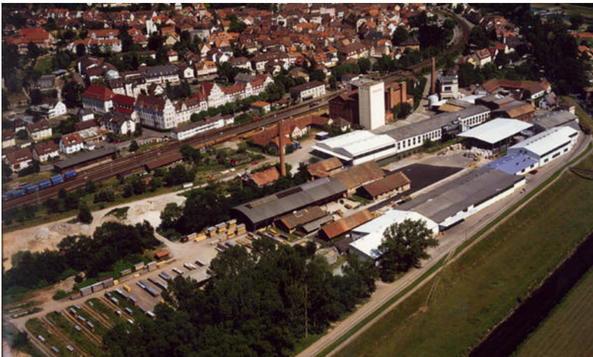
Abbildung 1: Luftbildaufnahme des Werksgeländes der Albert Köhler GmbH & Co. KG
