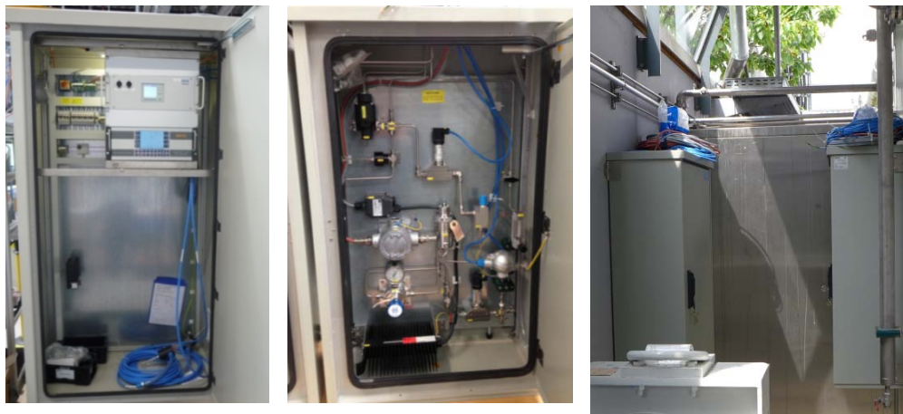
Abb. 61: Auswerteschrank (l.), Analysekasten (m.) und Montage an Tankstelle (r.)
