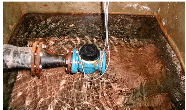
Wasserzähler Hesselbrunnen-Quelle
