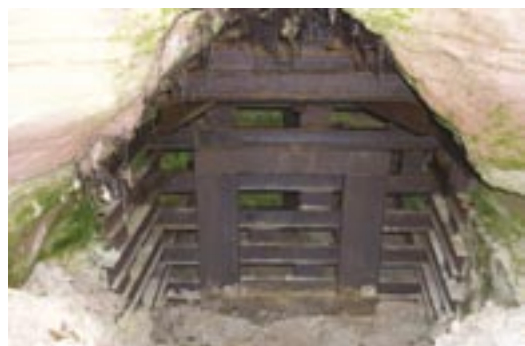
Großflächige Vergitterung eines Quartiers bei Lambertsberg (Deutschland).
