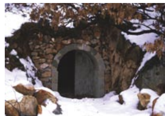
Eingang des Király-bányák Bergwerks nach der Umgestaltung und Optimierung.
