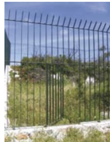
Tür in einem Zaun.
