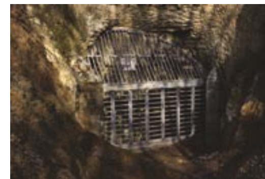
Vergitterter Kalksteinstollen in Norfolk (GB).
