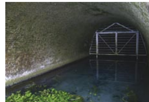
Gitter am Eingang des Greywell-Tunnels.
