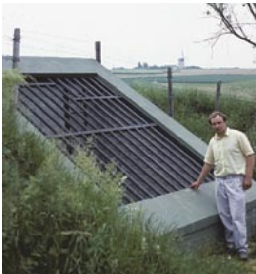
Großes vergittertes Bergwerk in Süd-Limburg (Niederlande).
