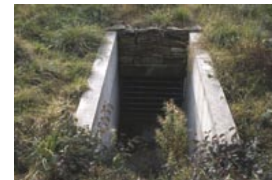
Kleiner vergitterter Stollen in hügeligem Gelände (GB).
