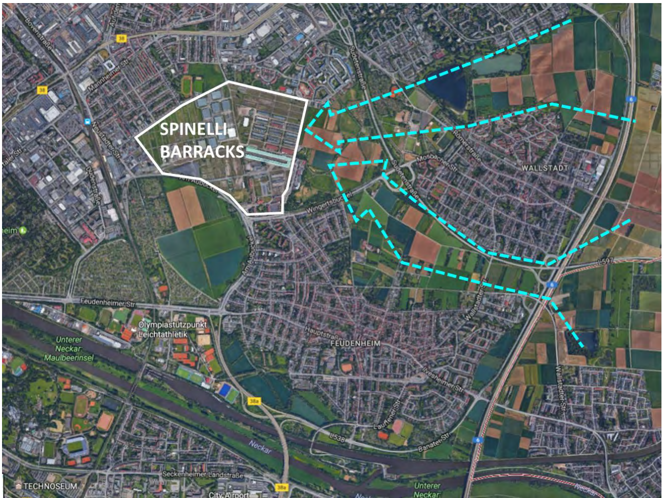
Abbildung 7: Blick auf die noch bestehende Kasernenbebauung der Spinelli Barracks. Teile der Kasernenhallen werden bereits abgebaut, der letzte „Pfropfen“, der eine Strömungsdurchgängigkeit für bodennahe Kalt-/Frischluf von Außenbereichen in die Stadt hinein erschwert, wird damit gezogen. (Quelle: GoogleEarth, verändert; Zugriff am 31.03.2017)
