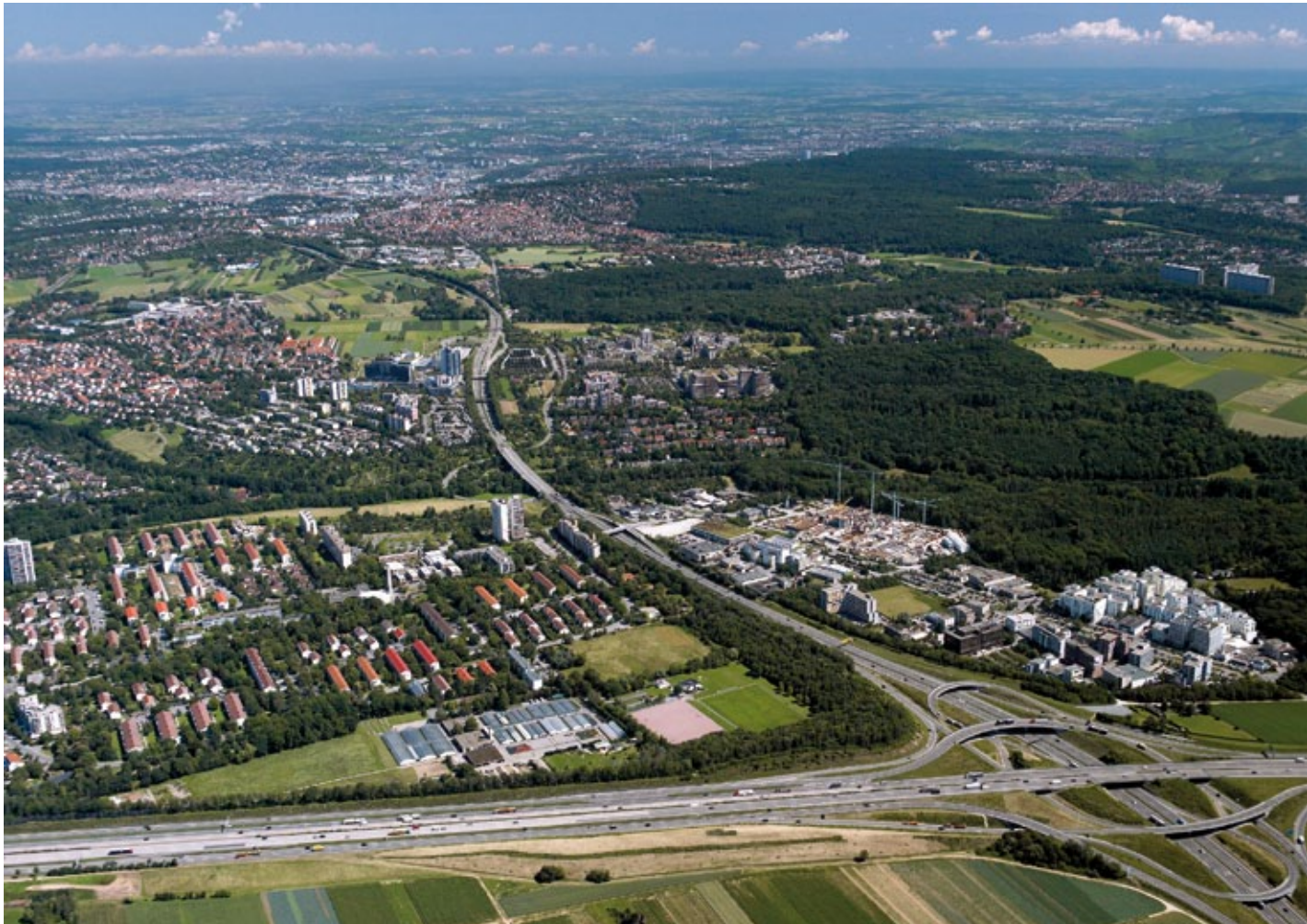
Abb. 9: Der Verkehrsknoten „Echterdinger Ei“ bei Stuttgart-Möhringen im Jahre 2007. Heute stehen anstelle der Kräne in der Bildmitte bereits die Hochbauten der EnBW-City. Foto: Arnim Weischer (LMZ)
